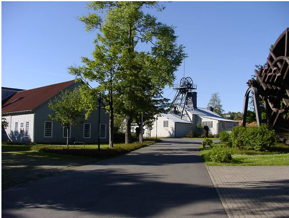
Kaiser-Wilhelm-Schacht, Betriebs Hof Clausthal der Harzwasserwerke GmbH
