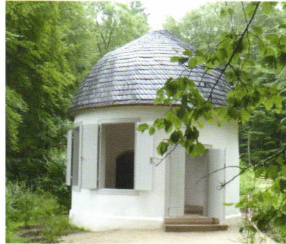
Abb. 22: Zaubershütte nach Fertigstellung
