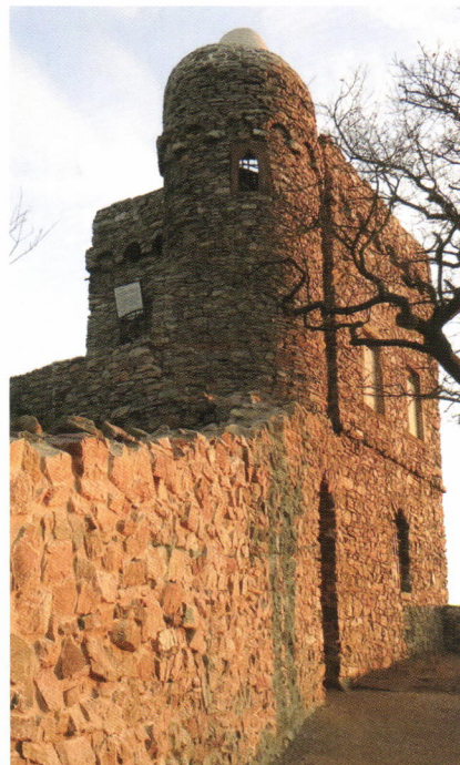
Abb. 23: Rossel nach Fertigstellung
