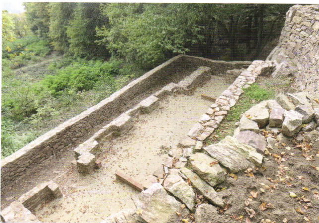
Abb. 11: Eremitage nach Sicherung der historischen Substanz
