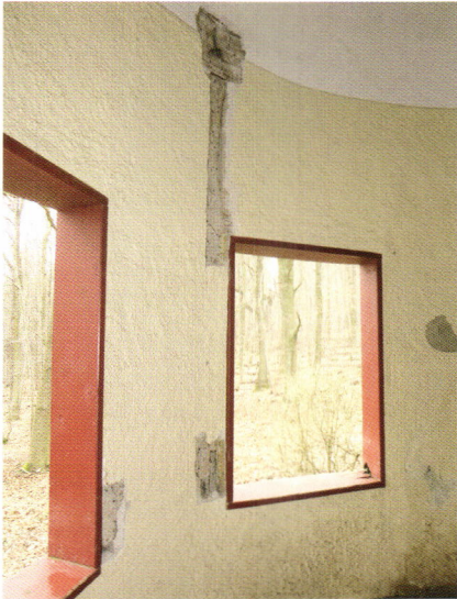
Abb. 15: Zauberhütte vor Beginn der Instandsetzung
