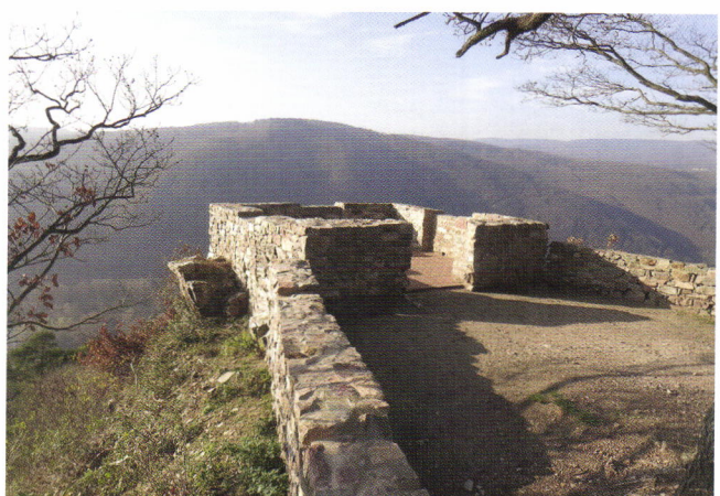
Abb. 14: Rittersaal nach Instandsetzung
