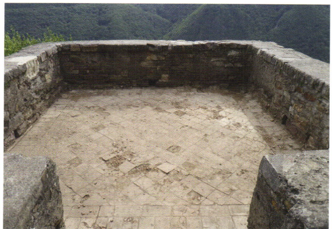
Abb. 13: Befund des originalen Ziegelfußbodens
