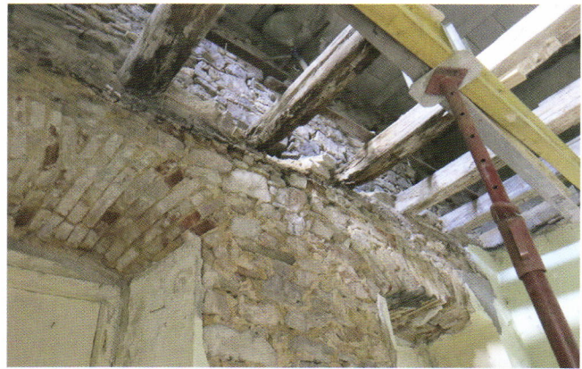
Abb. 20: Raum im Obergeschoss während der Instandsetzung
