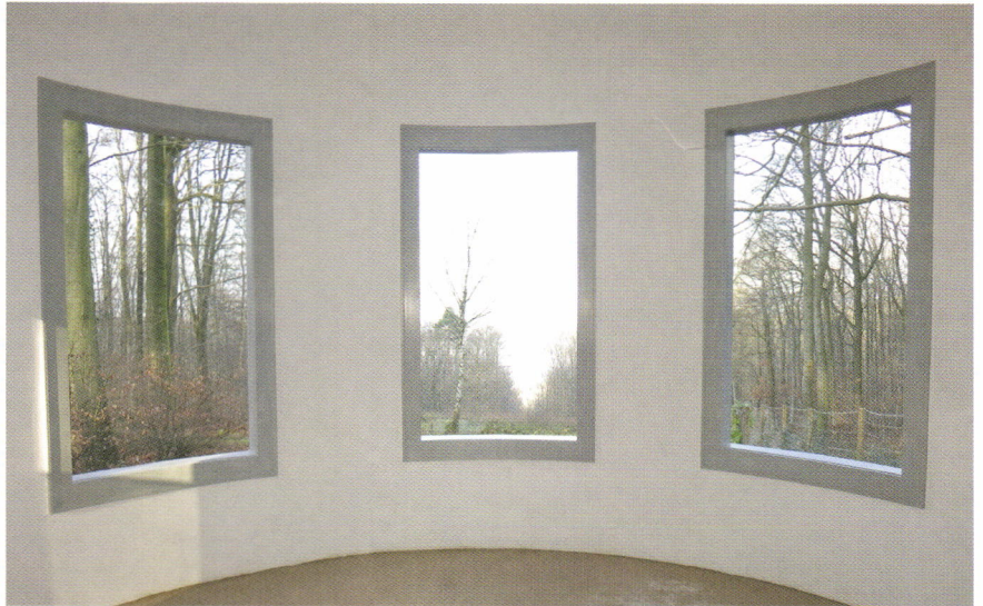
Abb. 16: Zauberhütte nach der Instandsetzung mit Wiederherstellung der historischen Fensterhöhen
