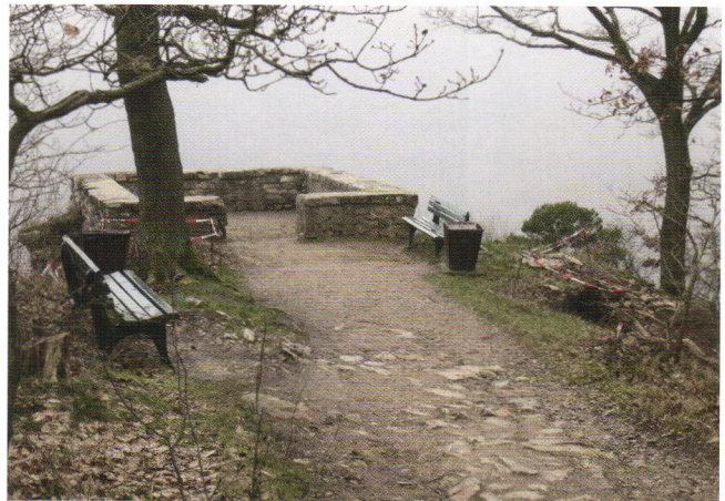
Abb. 12: Der Rittersaal vor Beginn der Instandsetzung
