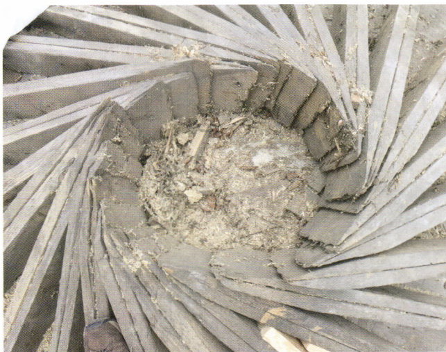
Abb. 17: Dachwerk der Zauberhütte während der Instandsetzung
