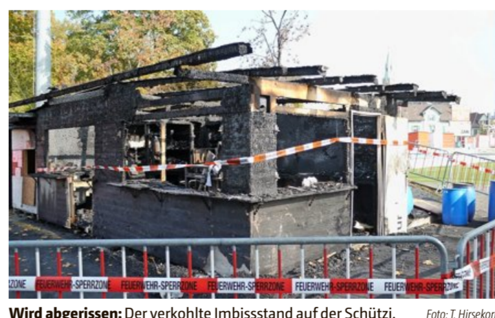
Wird abgerissen: Der verkohlte Imbissstand auf der Schützenwiese. Foto: T. Hirsiger
