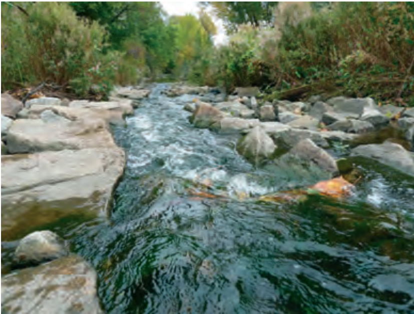
Das ehemalige Wehr an der Hundemühle (Holtemme) im Ortsteil Minsleben (Stadt Wernigerode) wurde 2008 durch einen Rückbau (rechts) in ein Raugerinne fischpassierbar umgestaltet (oben).
