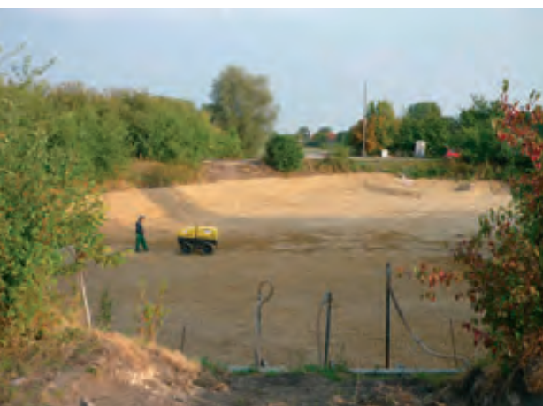
Durchführung der Teichabdichtung, August 2012
