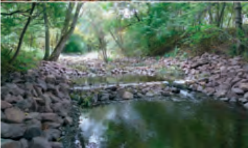
Abschlag Rote Mühle in Wernigerode (Holtemme) vor dem Rückbau (oben) und der Zustand nach Abschluss der Bauarbeiten (unten). Finanziert wurde der Umbau aus dem Europäischen Fischereifonds.
