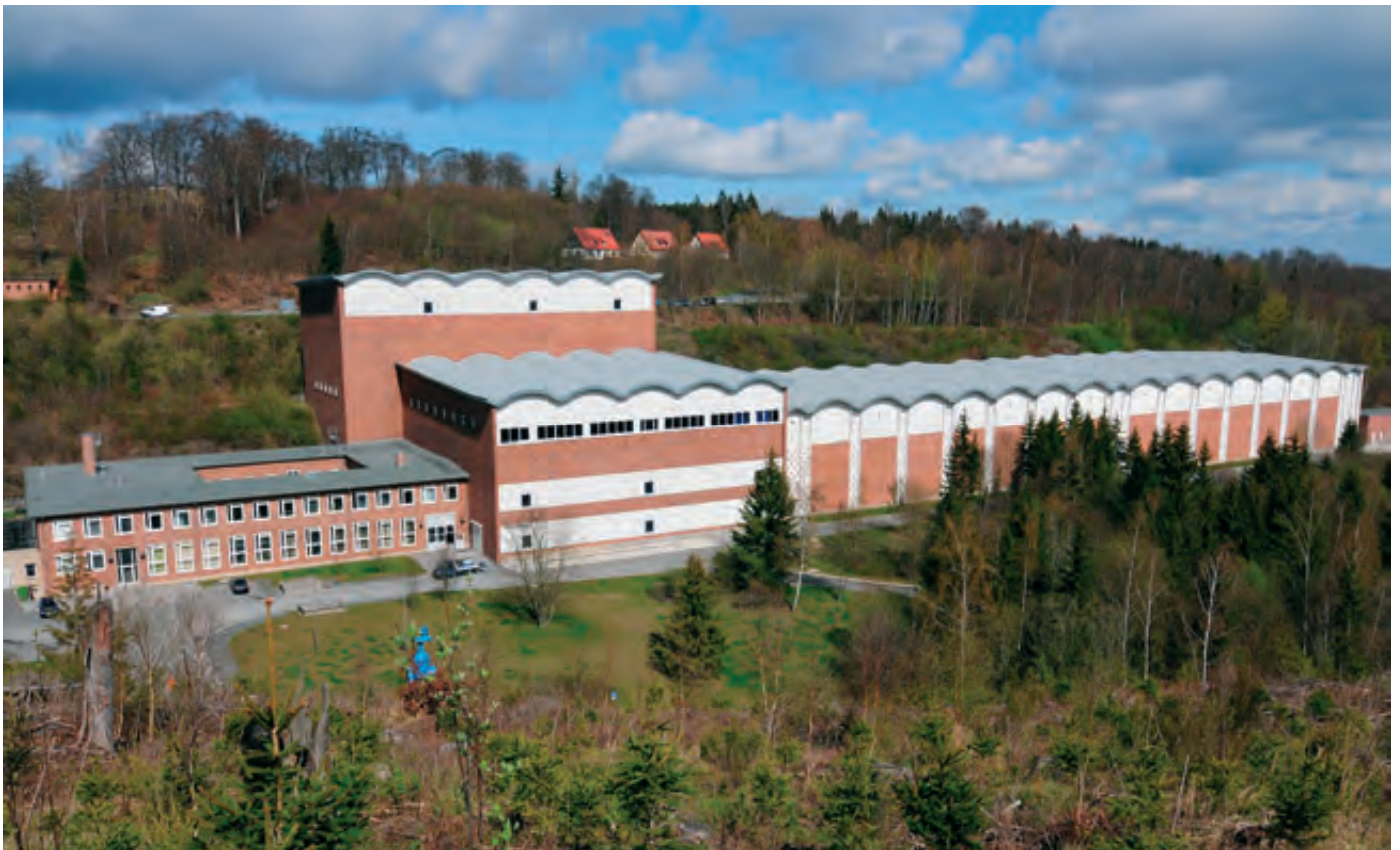
Das Wasserwerk Wienrode Foto: Fernwasserversorgung Elbaue-Ostharz GmbH
