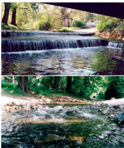
Querbauwerk am Bhf. Westerntor in Wernigerode (Zillierbach) vor dem Umbau (oben) und nach der Fertigstellung 2001 (unten). Foto: Ulrich Eichler
