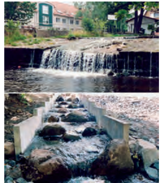
Querbauwerk an der Holtemme im Ortsteil Hasserode (Stadt Wernigerode) vor der Umgestaltung.
