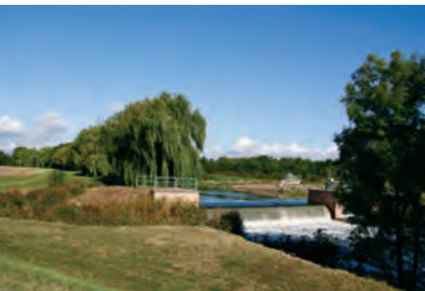
Wehr Klosterrohrbach mit Umgehungsgerinne Foto: Lutz Döring
