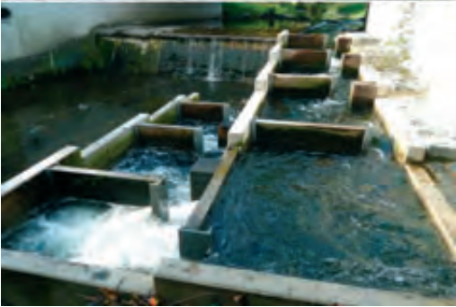
Querbauwerk an der Holtemme im Bereich Schmatzfelder Straße in Wernigerode vor dem Umbau (oben) und danach (unten). Gebaut wurde ein Fischaufstieg (Schlitzpass).
