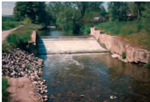
Das ehemalige Wehr an der Hundemühle (Holtemme) im Ortsteil Minsleben (Stadt Wernigerode) wurde 2008 durch einen Rückbau (rechts) in ein Raugerinne fischpassierbar umgestaltet (oben).
