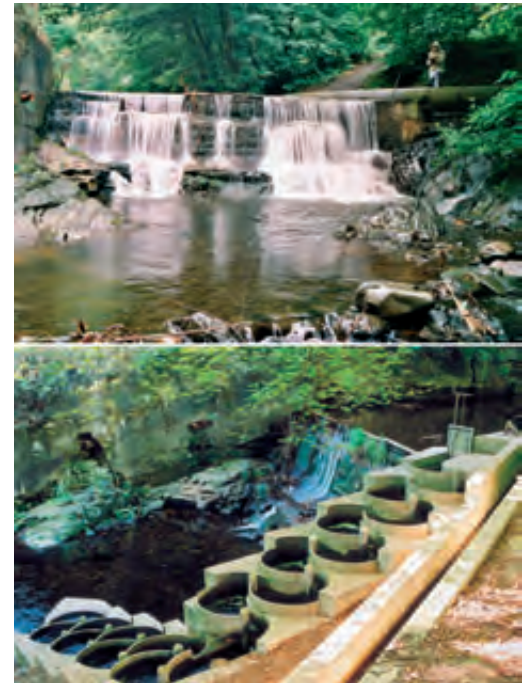
Für Fische unüberwindbares Querbauwerk an der Holtemme im Ortsteil Hasserode (Stadt Wernigerode) vor dem Umbau (oben).
