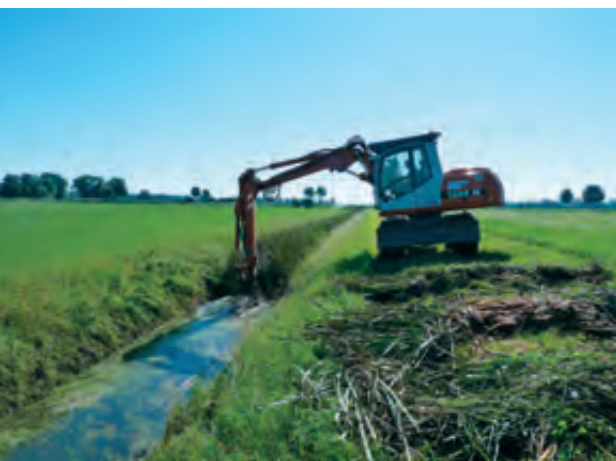
Gewässerkrautung mittels Mähkorb Foto: Wüstemann
