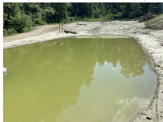
Abbildung 10: Temp. Gewässer, Folienabdichtung
