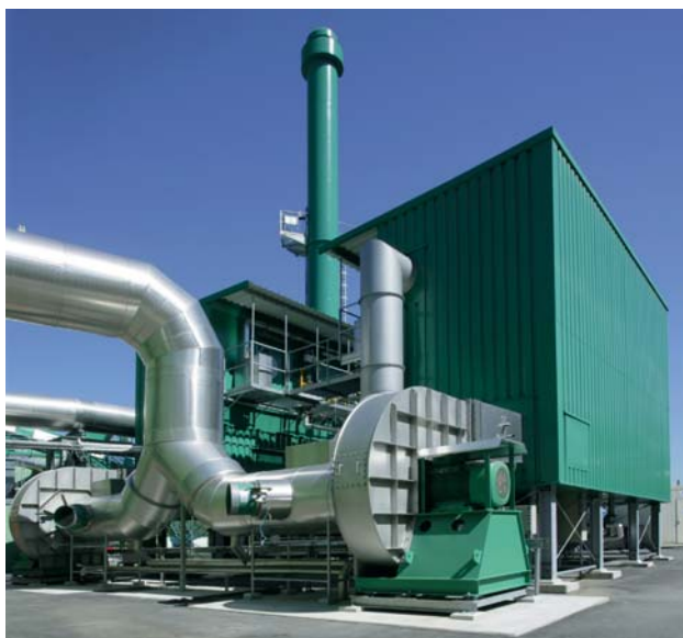
Große Ventilatoren leiten der Regenerativ-Thermischen Oxidationsanlage (RTO) die stärker belastete Prozessabluft zu.
