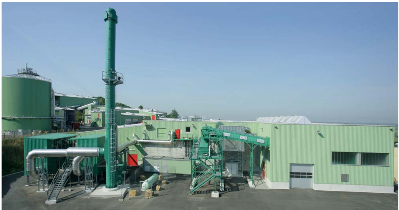
Ostansicht der Halle der Biologischen Trocknung. Links davon befindet sich die Abluftbehandlungsanlage mit dem Kamin und der Regenerativ-Thermischen Oxidationsanlage (RTO).
