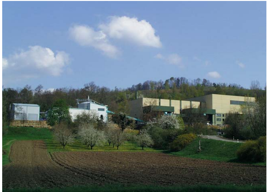
Die Demonstrationsanlage im Frühjahr 2001: Rechts die ehemalige Abfallaufbereitungsanlage für Sperr- und Gewerbemüll, in der nun die Hausabfälle mechanisch aufbereitet wurden (gelb-grünes Gebäude), links die Biologische Umsetzung und die Verlade- und Lüftungstechnikhalle (grau-grüne Gebäude).
