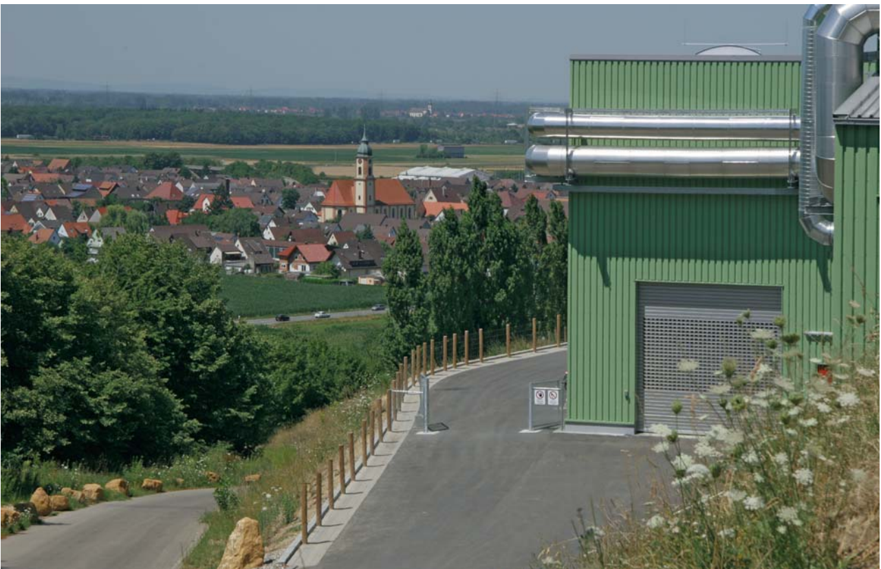
Die in den verschiedenen Anlagenteilen abgesaugte Abluft wird über isolierte Edelstahlleitungen der Abluftbehandlungsanlage zugeführt. Im Hintergrund liegt die Gemeinde Ringsheim.
