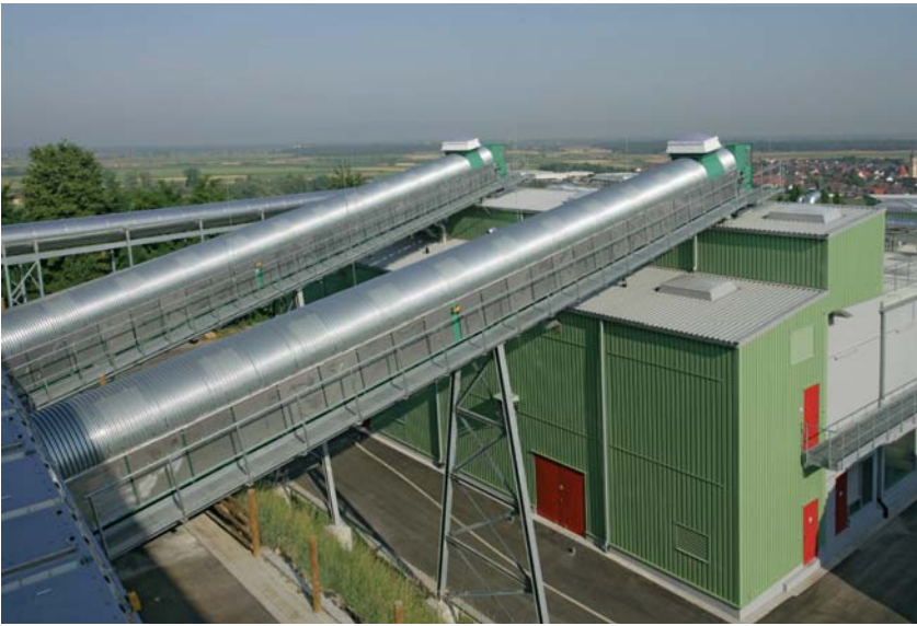
Zwei eingekapselte Förderbandlinien transportieren den mechanisch aufbereiteten Abfall zu den Perkolatoren.
