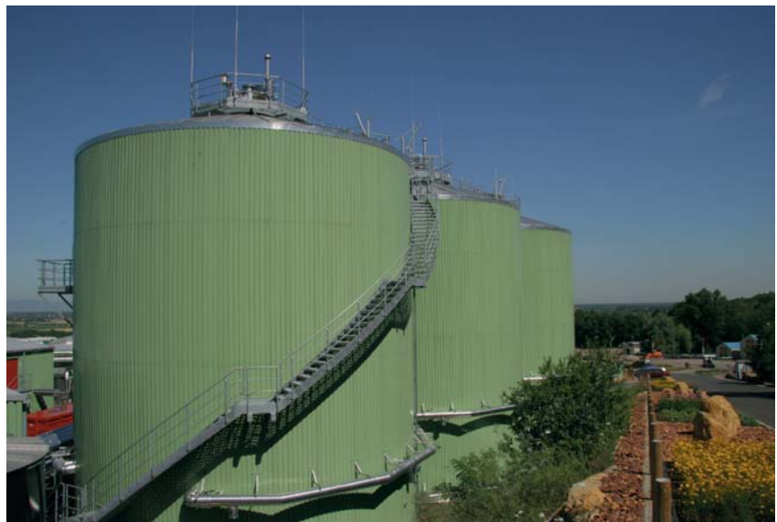
2 Millionen Liter Flüssigkeit passen in jeden der drei Biogas-Fermenter.
