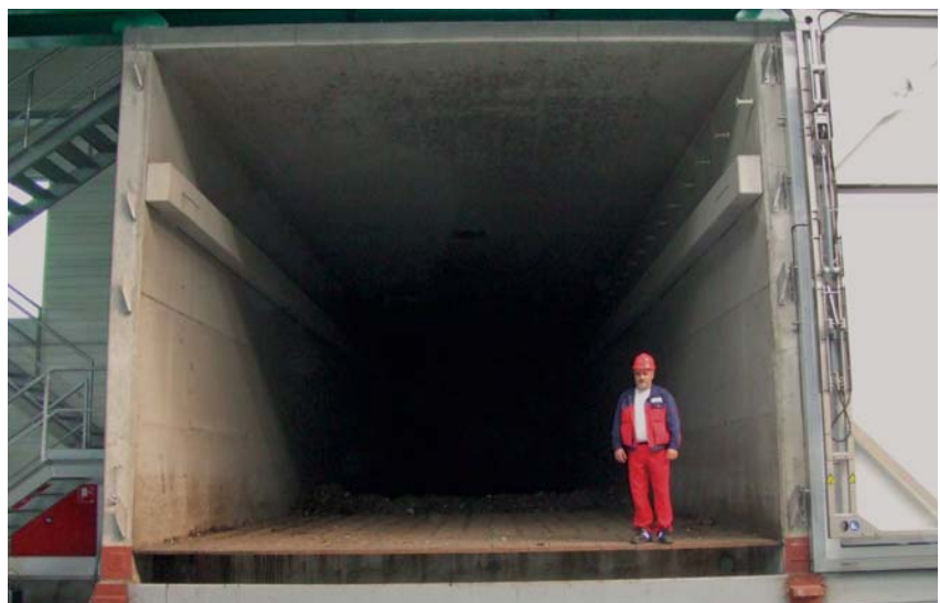
Jeder dieser 30 m langen und 6 m breiten Tunnel fasst rund 500 Kubikmeter des zu trocknenden Materials. Es kann mit dem in den Tunnel eingelegten Förderboden später wieder heraustransportiert werden.
