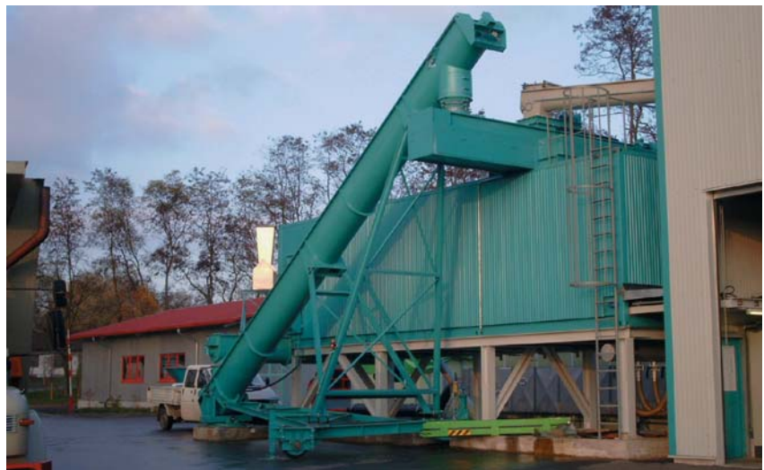
Modul zur Biologischen Trocknung in der Demonstrationsanlage: Die steil aufragende Förderschnecke war schwenkbar und konnte deshalb sowohl zum Umsetzen des angetrockneten Materials (Bild) als auch zum Entleeren des Trocknungsmoduls verwendet werden.
