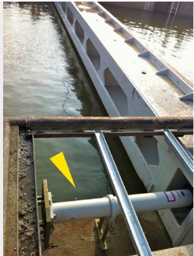
Speziell für diesen Einsatzfall ausgelegte schwere Sicherheitsstoßdämpfer bremsen in Schleuse Massen von bis zu vier Millionen kg ab Mourik Limburg BV, 6101 AJ Echt, Niederlande
