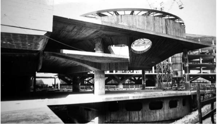
Rohbaufoto Sala Consiliare
