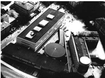
Luftbild Palazzo della Regione in Trento. Links das Edificio Assessorati, vorn die Giunta, dahinter die Sala Consiliare, rechts das ältere Hotel Trento.
