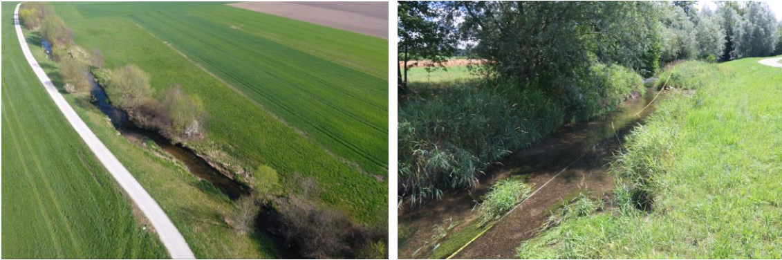
Abbildung 3-3. Die Strecke 2 liegt im revitalisierten Bereich der Bünz. An diesem Standort wurde die Bünz in einem leicht pendelnden Gerinne ausgebaut.
