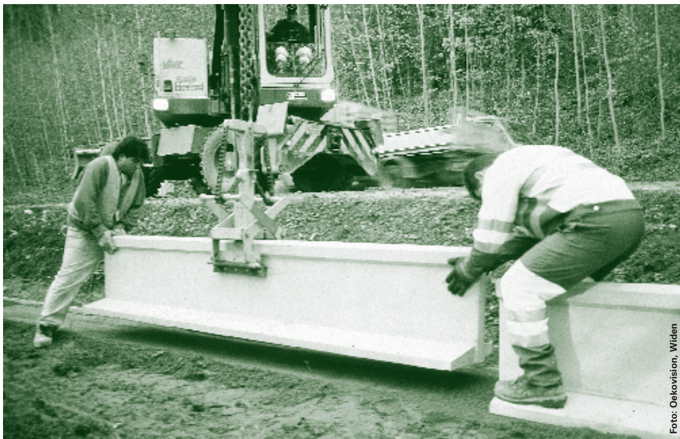
Entlang der Strasse weisen Beton-Leitelemente den Amphibien den Weg zu den Durchlässen.
