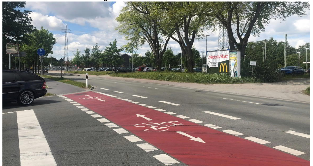
Abb. 23 Markierung Zweirichtungsradweg Furt (Papenburg)
