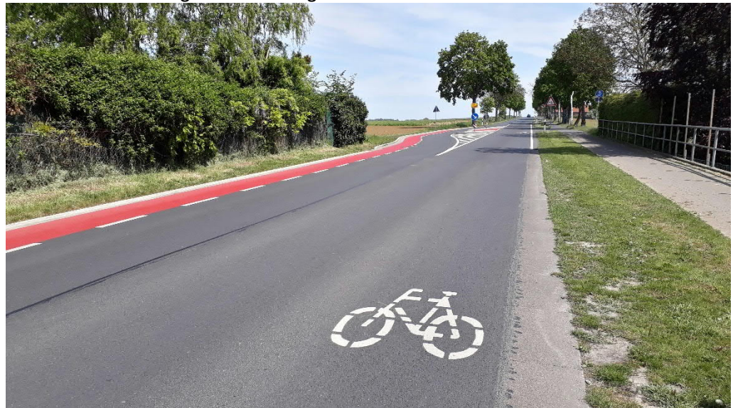
Abb. 21 Einseitige Markierung von Schutzstreifen und Markierung von Fahrradpiktogrammen auf der Fahrbahn (Seelze)
