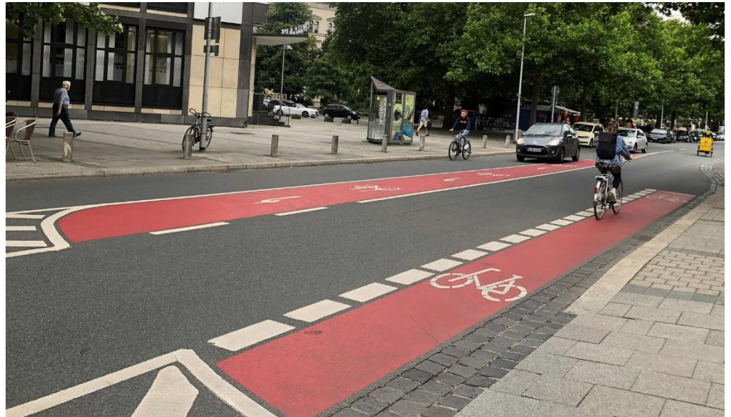
Abb. 22 Führungshilfe Radwegende (Hannover)
