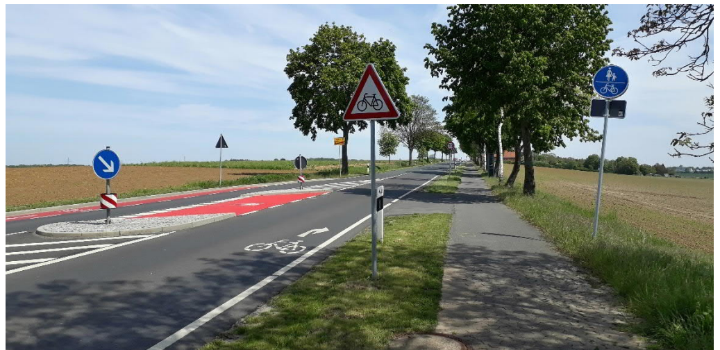
Abb. 19 Markierung von Fahrradpiktogrammen auf der Fahrbahn Übergang Fahrbahnführung innerorts und außerorts benutzungspflichtige RVA (Seelze)
