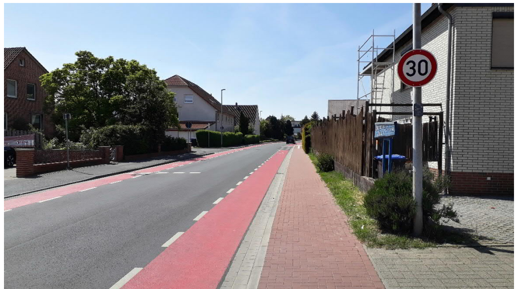
Abb. 17 Eingefärbte Schutzstreifen in Kombination mit Tempo 30 in Harenberg (Seelze)
