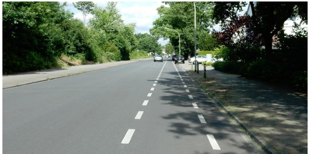
Abb. 20 Einseitige Markierung von Schutzstreifen (Osnabrück)
