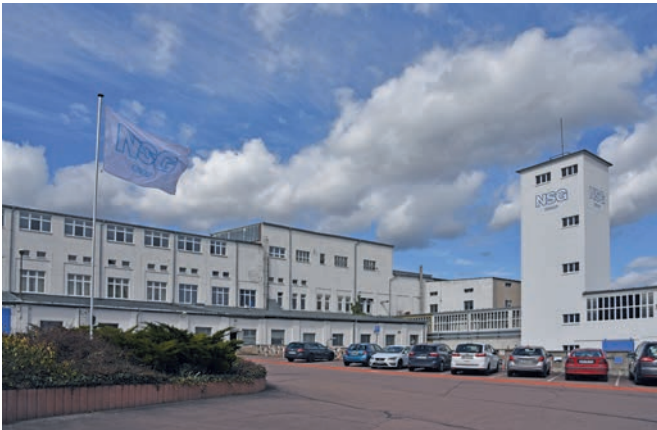
2018 – Ansicht von vorn auf das Fahrzeugglaswerk
