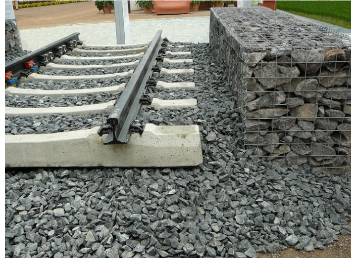
Bild 5-10: Niedrige Lärmschutzwand in Gabionenform
