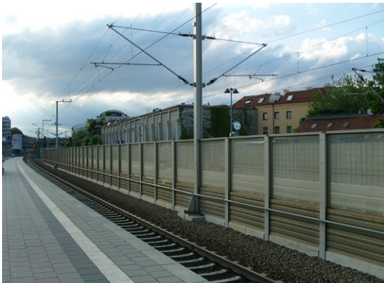
Bild 5-17: Aktive Schallschutzmaßnahmen in Form von Mittelwänden
