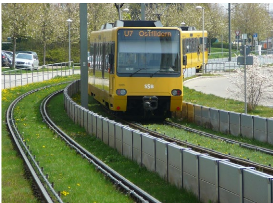
Bild 5-18: Straßenbahnlinie in Ostfildern: Rasengleis, niedrige Lärmschutzwand und Schienenbewässerung gegen Kurvenquietschen
