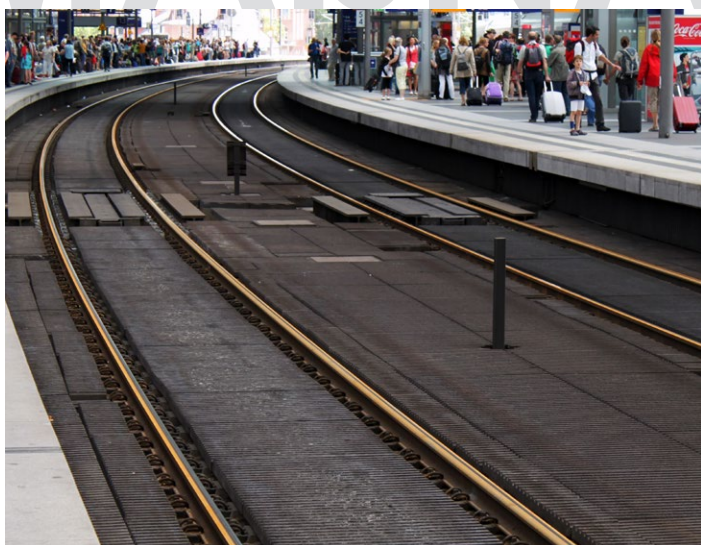
Bild 5-1: Absorberplatten auf fester Fahrbahn
