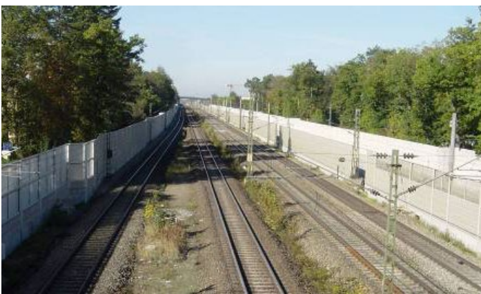
Bild 5-16: Schallschutzwände an einer mehrgleisigen Bahnstrecke
