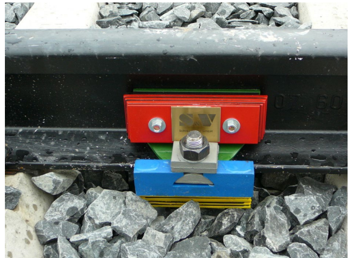
Bild 5-9: Schienenstegdämpfer
