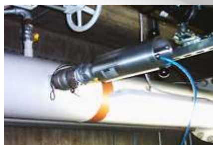
Eine passende Ausfahrarmatur ermöglicht eine einfache Reinigung der Schlammleitung bei eingebautem Sensor.
