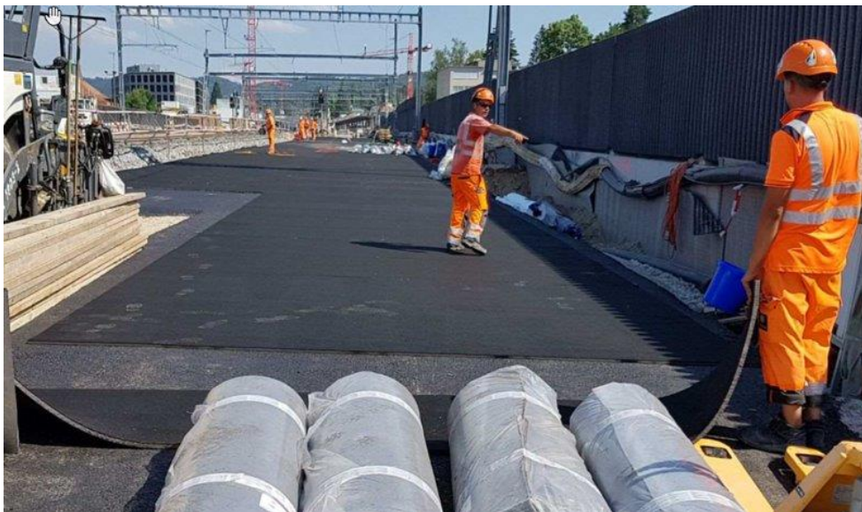
Abbildung 29: Installation einer UBM auf eine hydraulisch gebundene Tragschicht in Liestal (CH)
