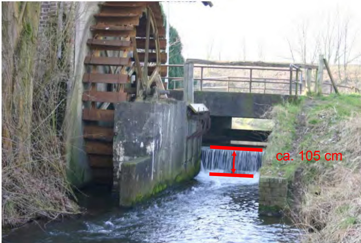
Durchlass und Staustufe an der Mühle Birten
