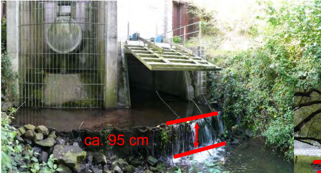
Sohlabsturz an der Mündung Winnenthaler Kanal
