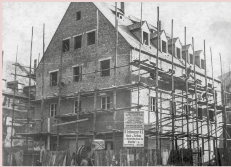
Wiederaufbau der Königstraße 6 in den Jahren 1948/49
