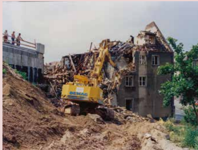
Die Stadthalle als Aussichtsplattform für den Abriss
