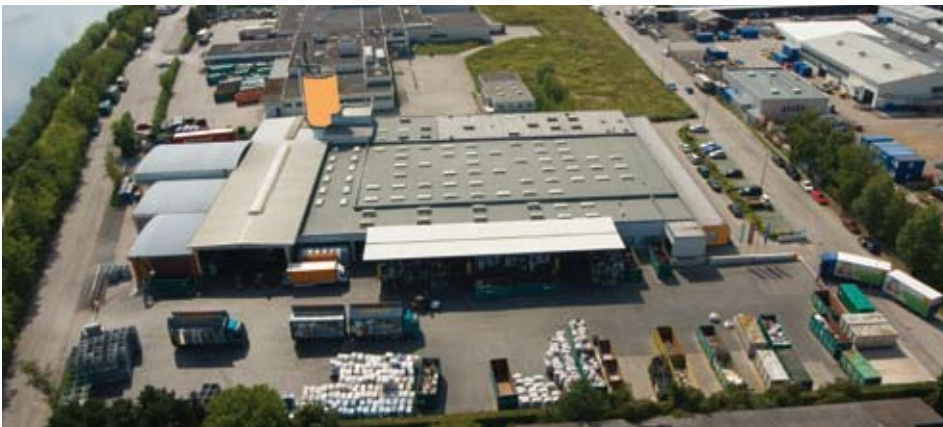
Abfall-Logistikzentrum in Wels
