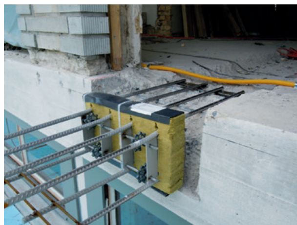
Anschluss an bestehendes Gebäude (mit Niveau-Versatz)
