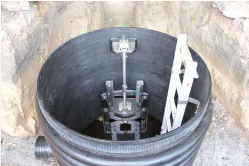
Drosselschacht DN 1200 mit mechanische VA-Drosselschieber für Regenrückhaltung
