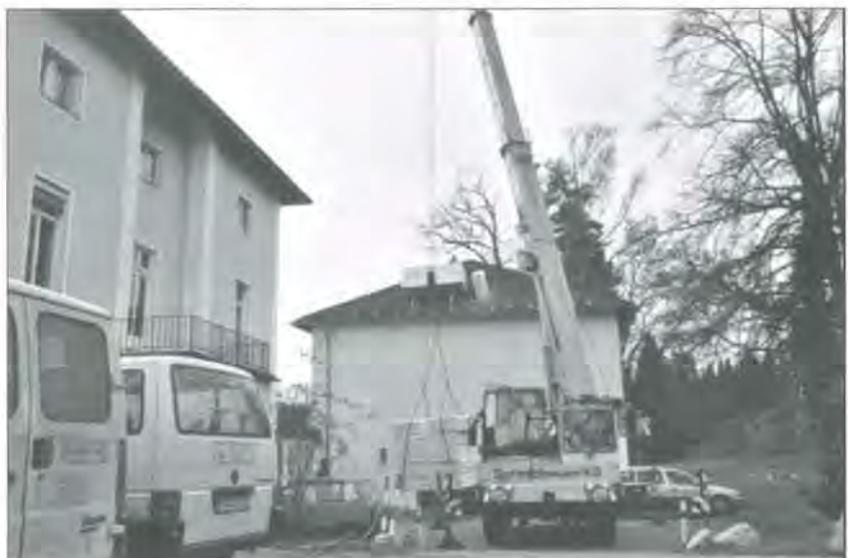
Weitreichende Sanierungs- und Renovierungsarbeiten prägten das Bild der Akademie im Dezember und in den Weihnachtsferien. Wärmedämmung in den Gästezimmern und im großen Hörsaal (unser Bild zeigt den Transport der Dämmplatten auf den Dachstuhl) sowie neue Fenster auf den Pavillonfluren und im Speisesaal werden in Zukunft die Heizkostenrechnungen deutlich mindern.
