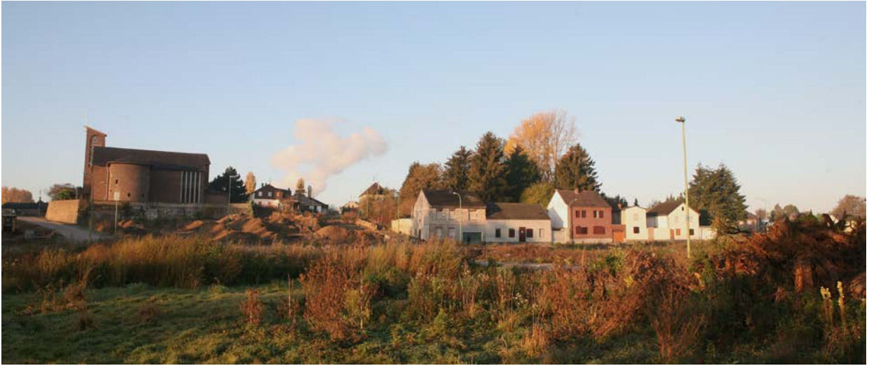
Abb. 1: Ansicht von Nordwesten auf den im Abbruch befindlichen Ort im Herbst 2011.
