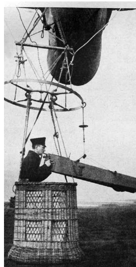
Befestigung einer Ballonkamera mit 120 cm Brennweite im Ballonkorb.
