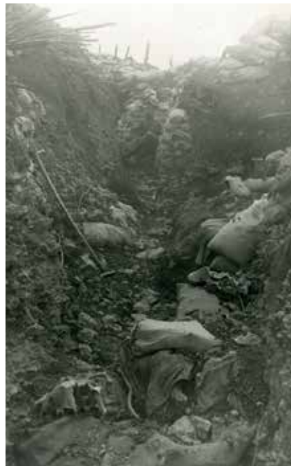
oben: In diesem Schützengraben wird die Grabenwand mit Faschinen bekleidet.
