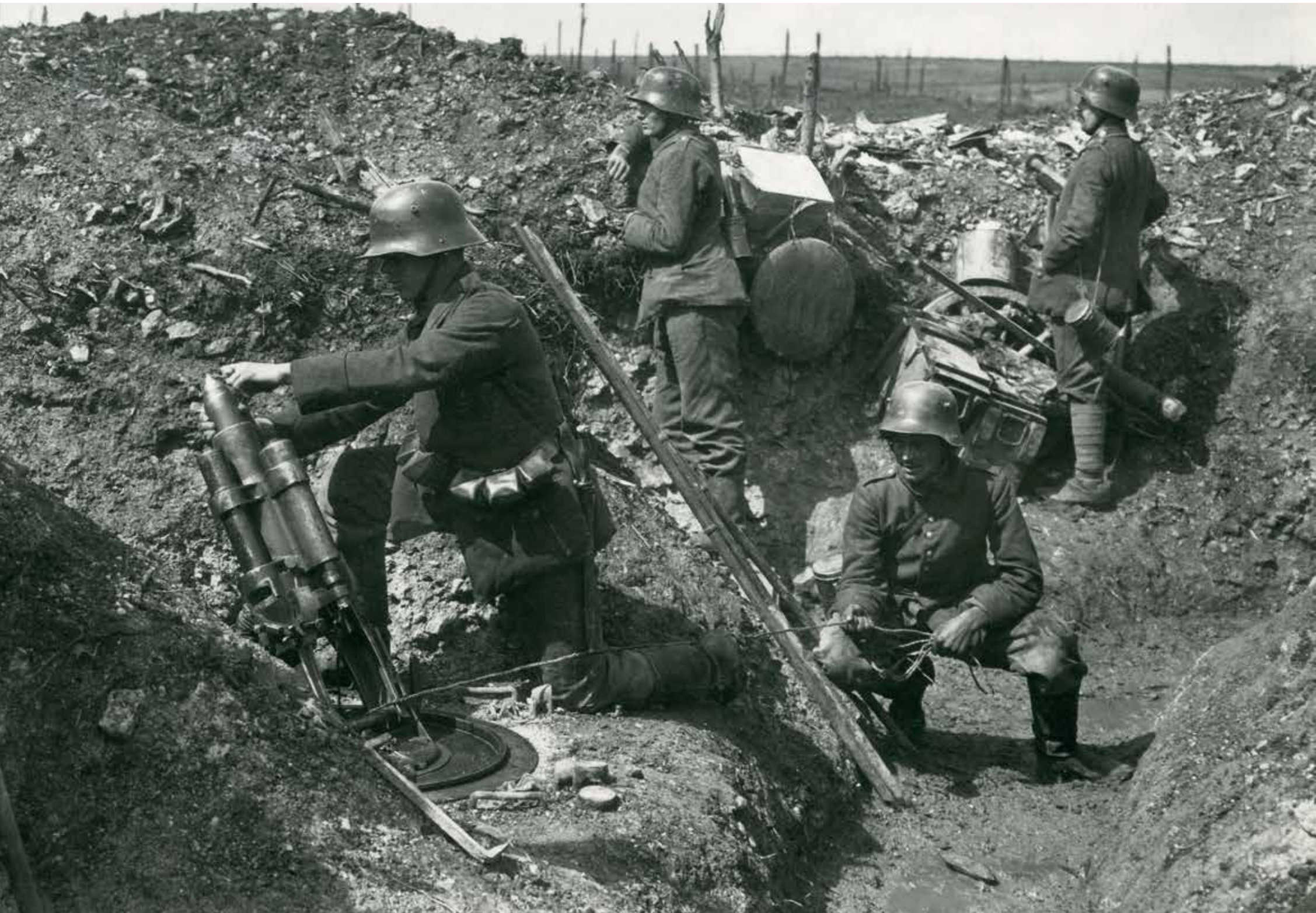
Laden eines leichten Minenwerfers, 1917/18. Minenwerfer waren Vorderlader. Bevor der Soldat die Wurfmine ins Rohr gleiten lässt, zieht er den Vorstecker aus dem Zünder, der dadurch aktiviert wird.
