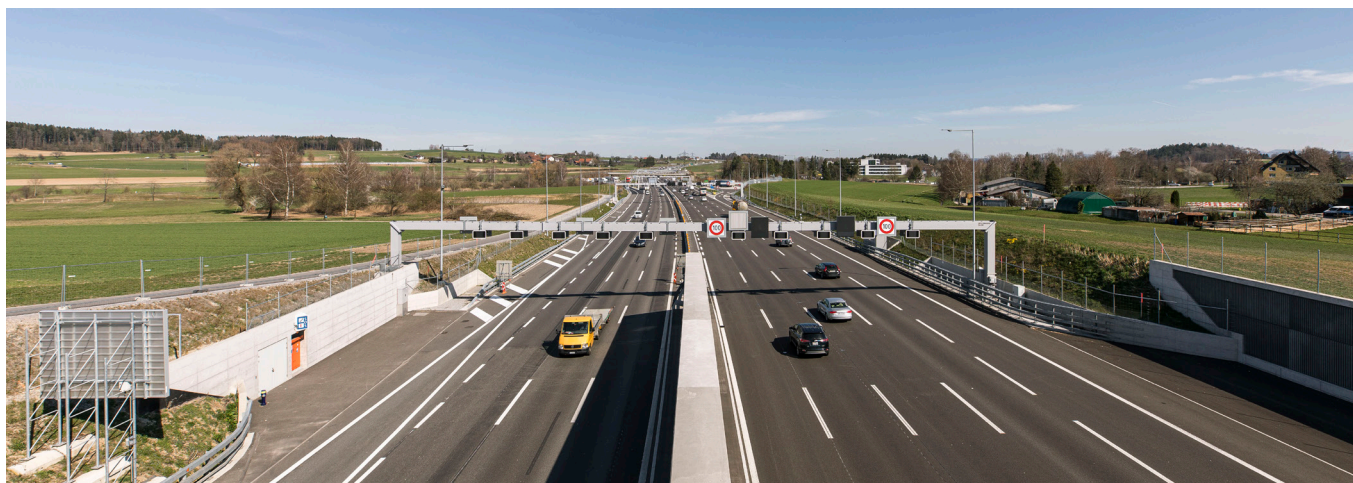
Der Verkehr bei der Überdeckung Katzensee fliesst dort auf vier Spuren Richtung St.Gallen und auf drei Spuren Richtung Bern.
