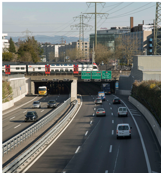
Der Stelzentunnel ist in beide Richtungen dreispurig befahrbar.
