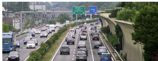
Zwischen Morges-Est und der Verzweigung Ecublens fliesst der Verkehr auch in den Stosszeiten, dank der Freigabe des Pannestreifens.
