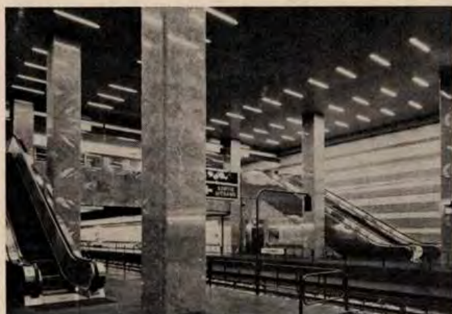
Im Bahnhof Diamant schafft die relativ dunkle Farbgebung der Decke aus rollgeformten beige-grauen einbrennlackierten Aluminiumpaneelen von Alcan zu den hellen Marmorwänden einen interessanten Kontrast.
