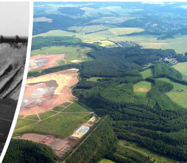
Absetzanlage Culmitzsch, Quelle: mapio.net Kontaminierter Schrott in Kassetten mit Beton vergossen; kontaminierter Bauschutt
