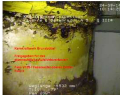
Ansicht oberes Fassdrittel mittels Inspektionskamera
