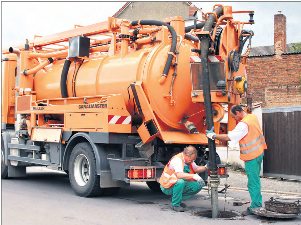
Herausputzen fürs Fernsehen: Bevor die Altkanäle mit kleinen, selbstfahrenden Kameras untersucht werden, kommt die „Putzkolonne“ mit ihrem Spülfahrzeug zum Einsatz.
