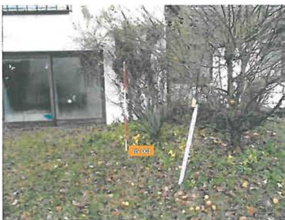
Abb. 2: Bereich BS 1, Blick nach Norden
