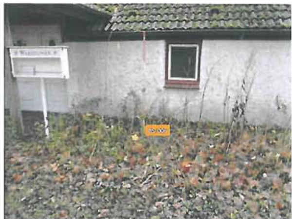
Abb. 7: Bereich BS 6, Blick nach Südwesten
