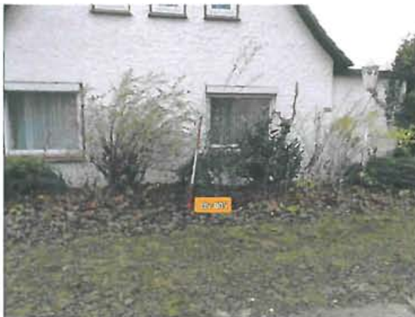
Abb. 6: Bereich BS 5, Blick nach Westen
