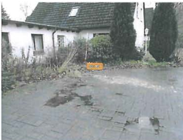
Abb. 8: Bereich BS 7, Blick nach Südwesten
