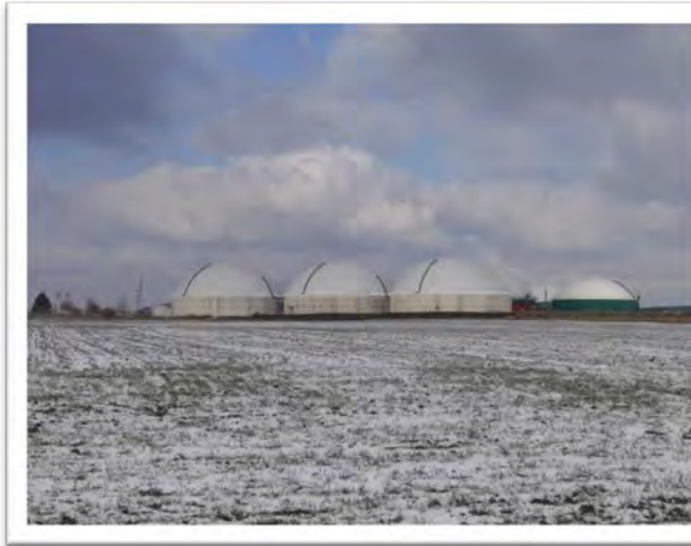
Bild 10: Biomethananlage vom Löbnitzer Weg aus
