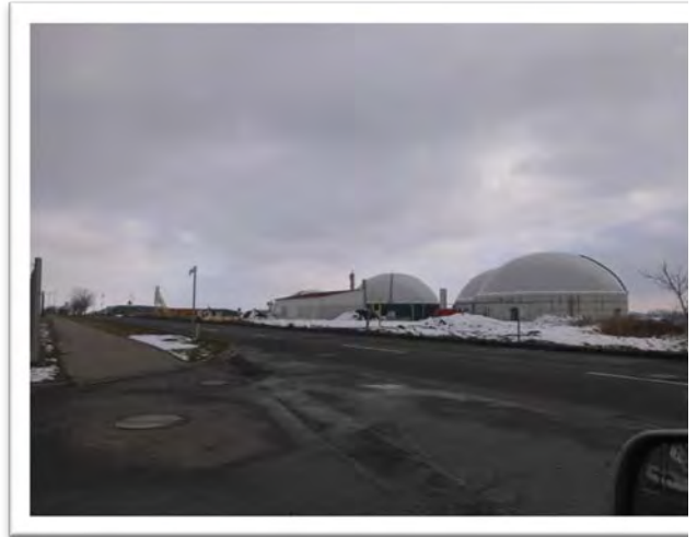
Bild 11: Biomethananlage von der Tierpension aus
