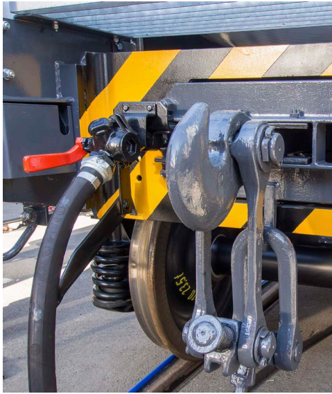
Abb. 3-9: Geöffneter Luftabsperhahn der HL bei einem Güterwagen
