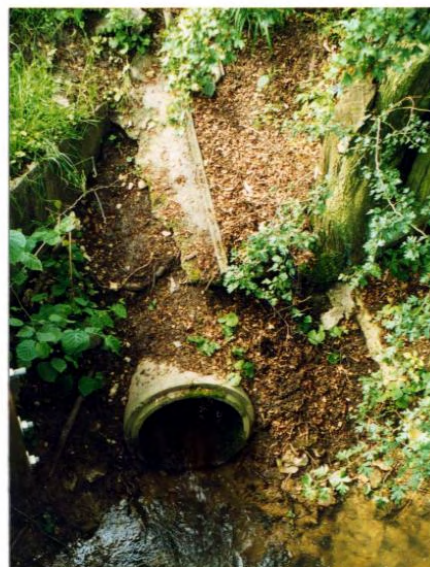
Einmündung des Leimattbaches in den Klusbach.
