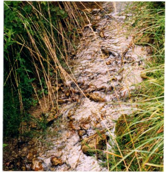
Lolibach kurz vor der Eindolung.
