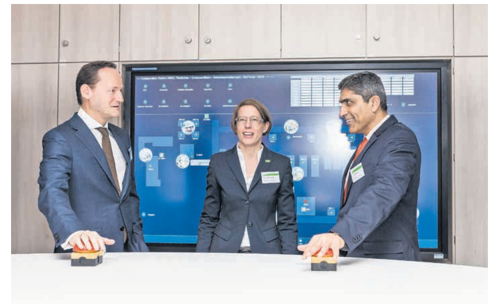
Die Messwarte wurde am 28. November offiziell eingeweiht: Dr. Karin Flore (ESI/AR), Betriebsleiterin der RVA, gab dem Werksleiter Dr. Uwe Liebelt (ES) und Vimal Kapur, President and CEO Honeywell Process Solutions, das Startsignal.
