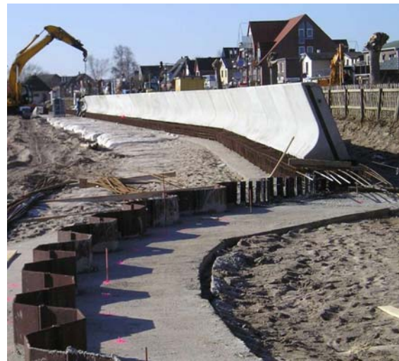
Photo 1: Einbau eines Spundwandes als Hochwasserschutz vor Scharbeutz.
