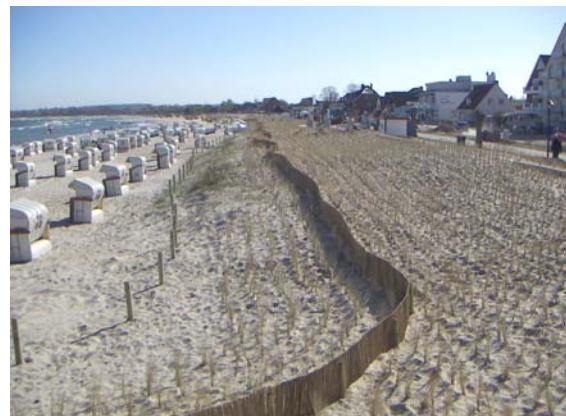
Photo 2: Anwerfen des Spundwandes mit Sand bzw. Wiederherstellung des Strandwalles.
