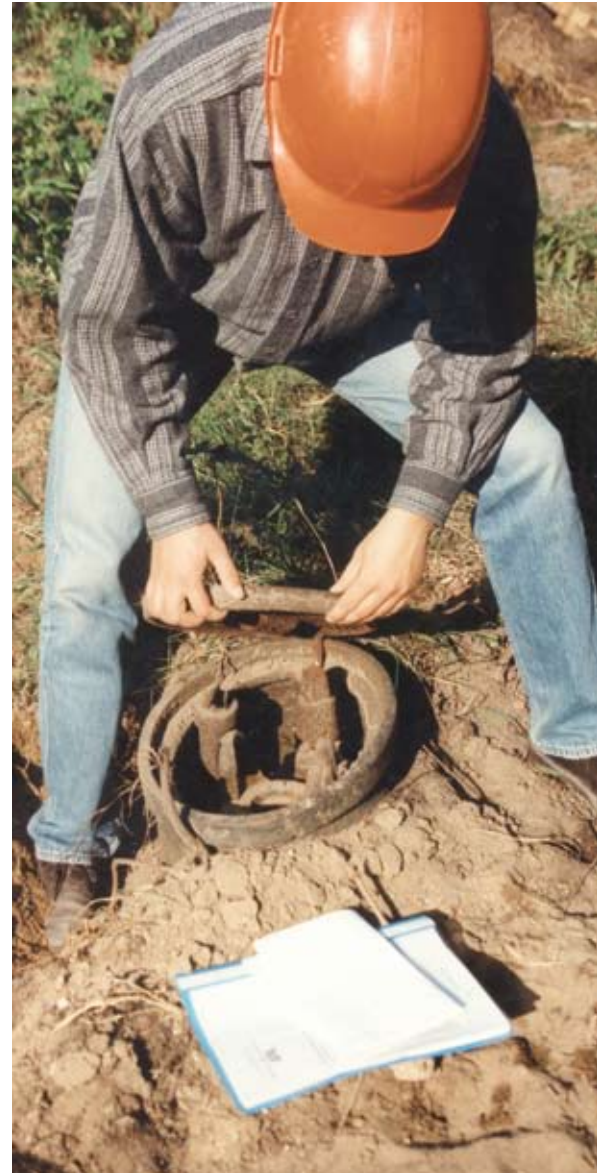
Abb. 2: Ermittlung von Lage, Art und Zustand von Ver- und Entsorgungsleitungen
