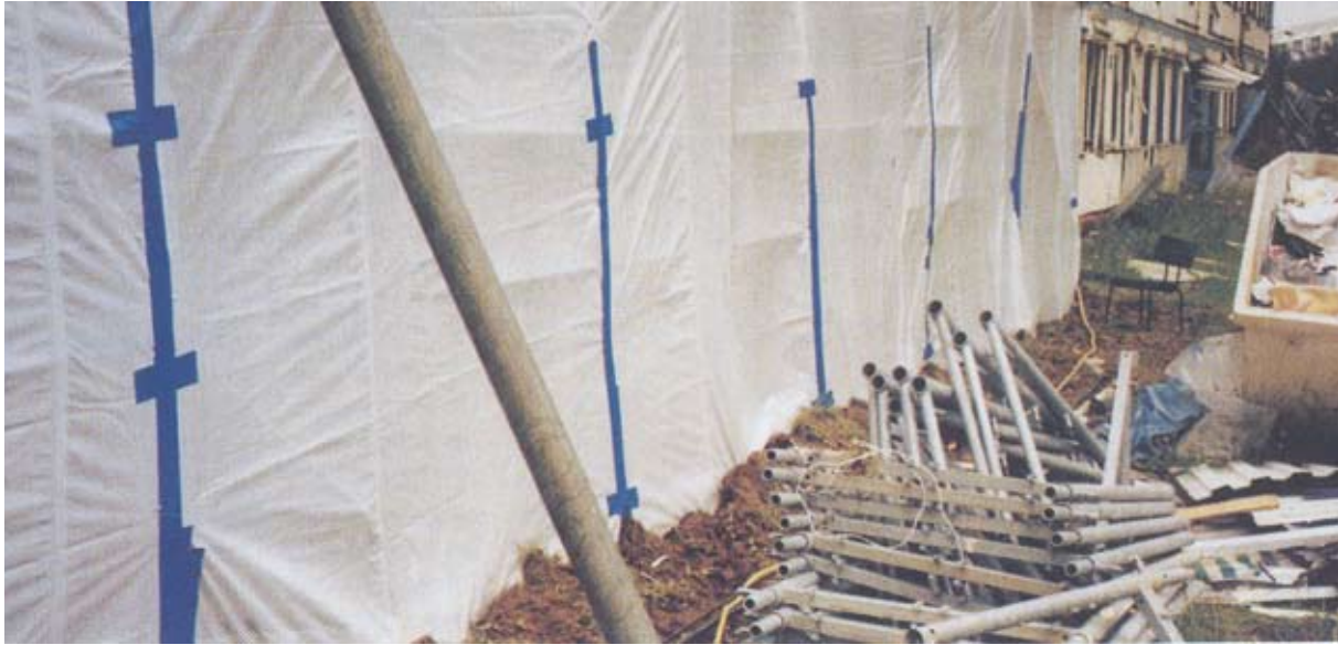
Abb. 9: Einhausung einer Abbruchstelle zur Verhinderung der Staubausbreitung
