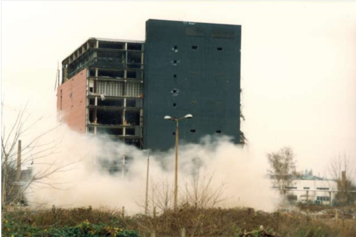
Abb. 7: Abbruch durch Sprengen
