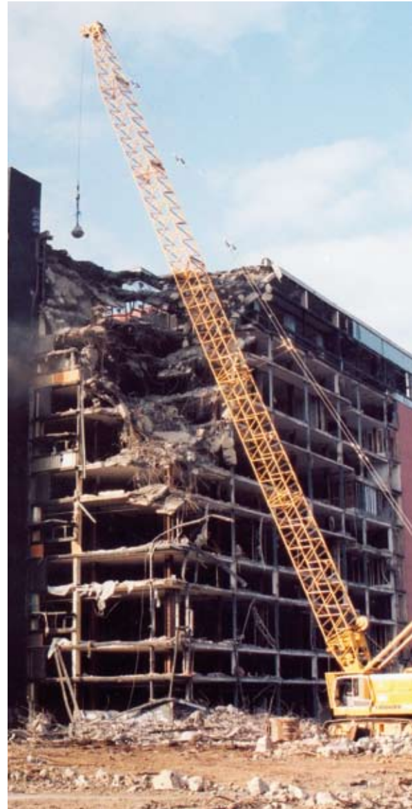
Abb. 3: Maschineller Abbruch mit Großgeräten
