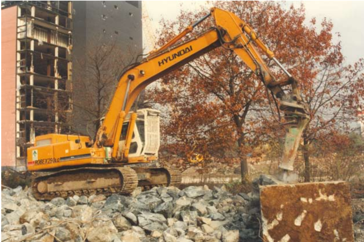
Abb. 8: Maschineller Abbruch mit Hydraulikhammer
