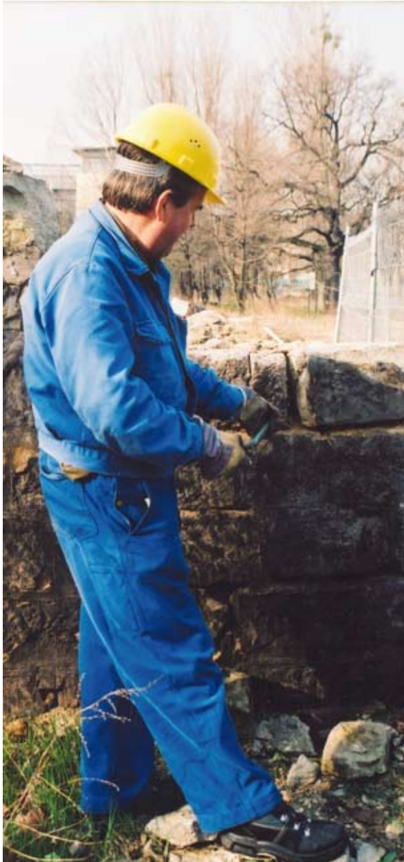
Abb. 5: Manuelles Abtragen von Mauerwerk mit einer Brechstange
