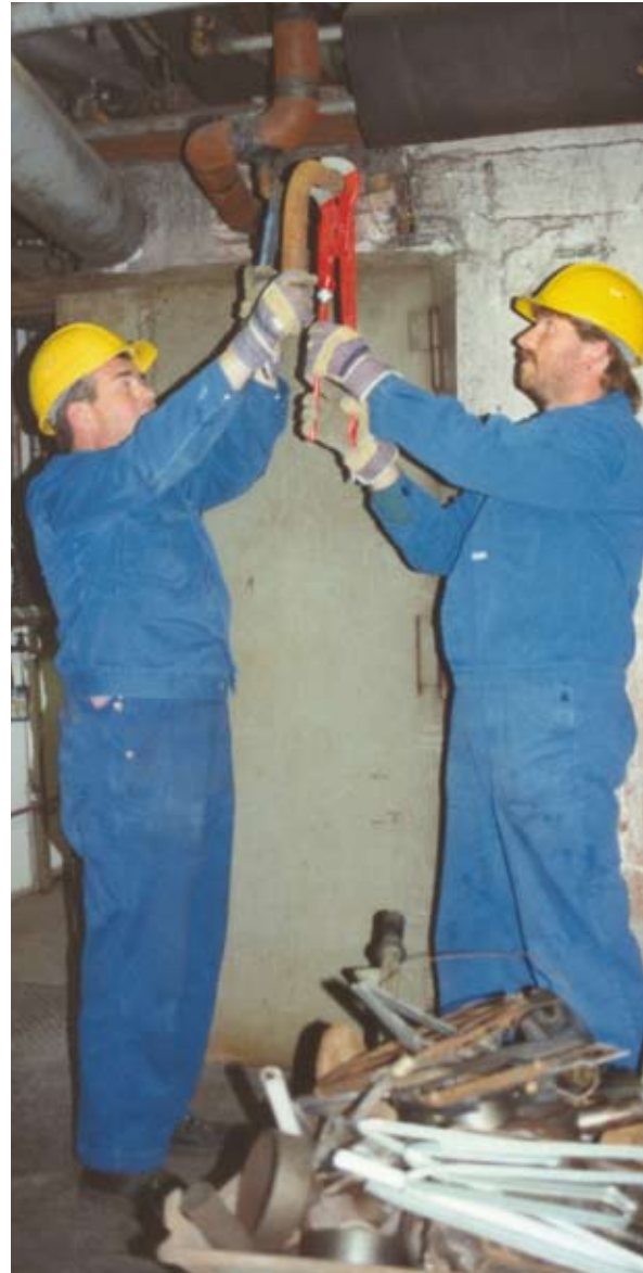
Abb. 6: Demontieren von Rohrleitungen
