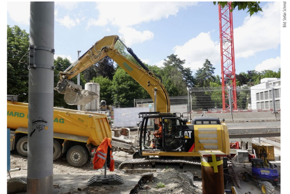
Der Abtransport des Abbruchmaterials war auf die Minute genau getaktet.
