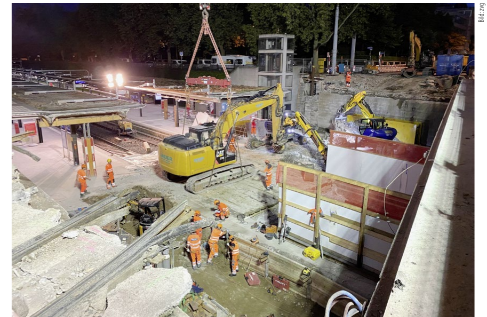
Der 60-Tonnen-Bagger biss sich vom Niveau der Perron aus durch den Beton der Brücke. Links im Bild sind die abgeschnittenen Tramschienen zu sehen.
