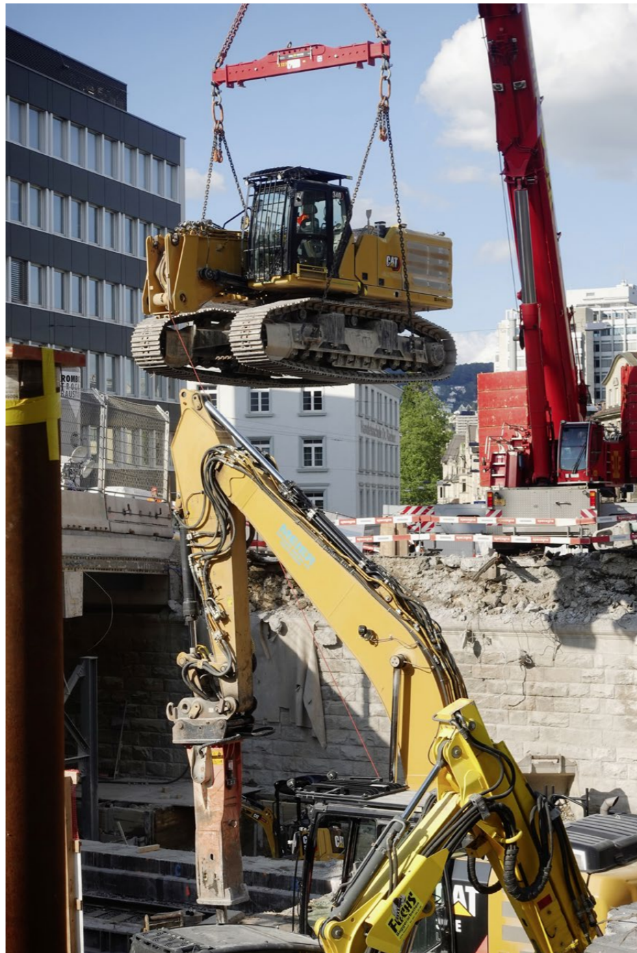
Am Freitag um 21 Uhr ging es nach mehrtägigen Vorbereitungsarbeiten mit dem Abbruch der Bederbrücke los. Am Sonntag war der Einsatz des 60-Tonnen-Baggers bereits beendet.
