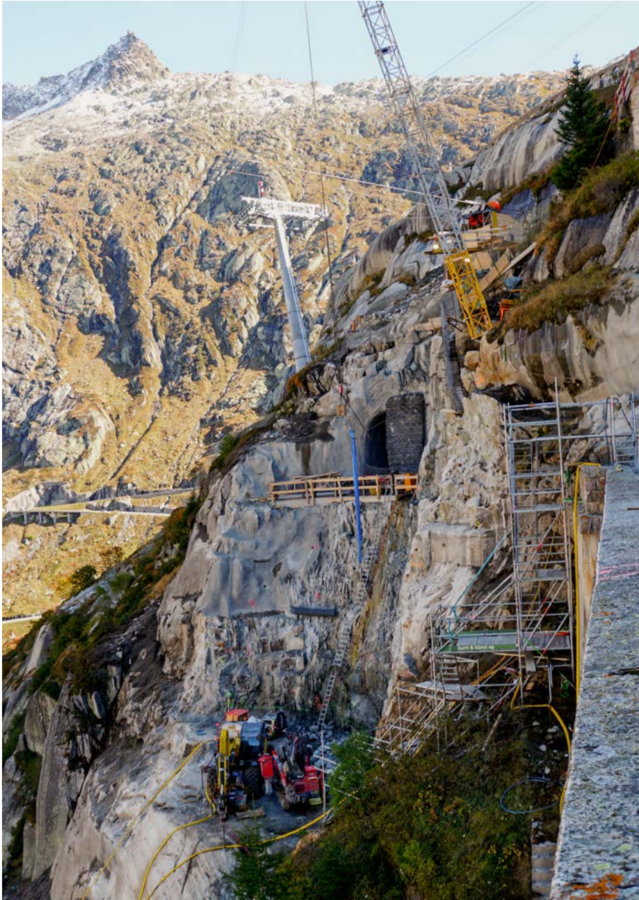
Der Seitenaushub legt das Widerlager der Staumauer frei. Die Zugangsstollen (oben) zur neuen sowie zur alten Mauer sind bereits durchstochen.
