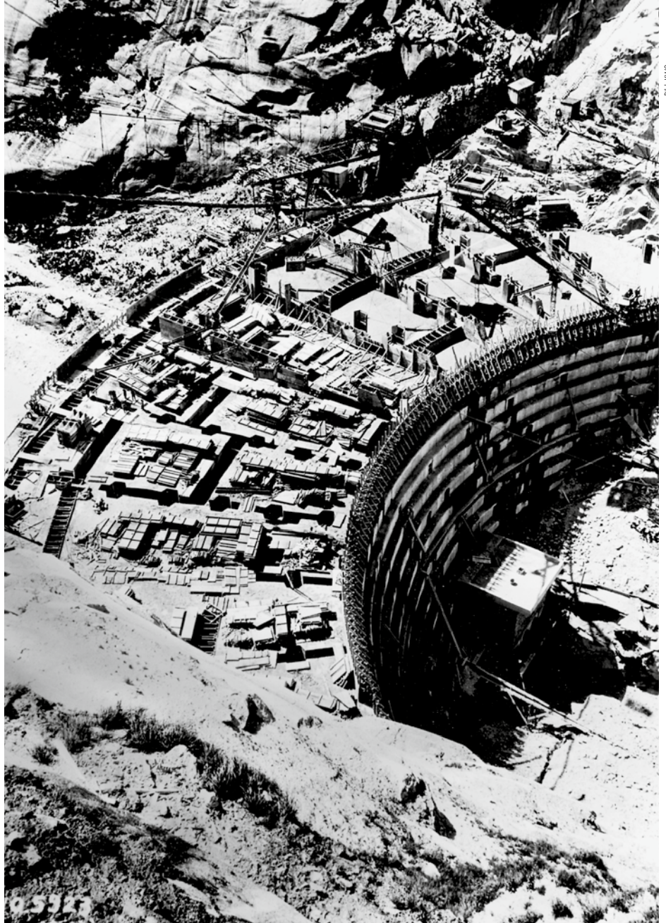
Die Bauwerkstrennung führte bei der alten Staumauer zu undichten Stellen, sodass in den 40er-Jahren Massnahmen ergriffen wurden.
