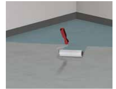
2 Grundierung des Untergrundes, z.B. mit ASO®-Unigrund
