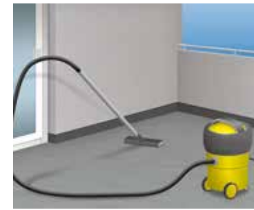
1 Geeigneten tragfähigen Untergrund gründlich reinigen
