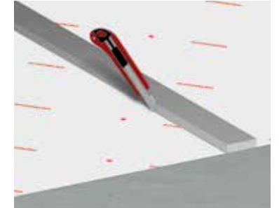
4 Zuschneiden der ADF®-Balkonfolie
