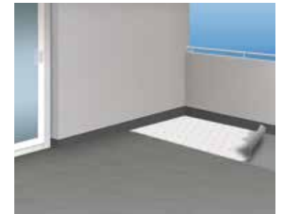
6 Einbetten der ADF®-Balkonfolie in das frische Klebebett
