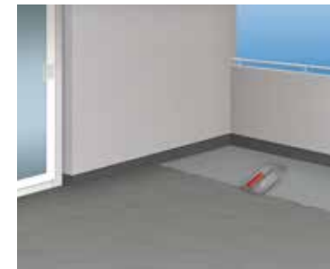
5 Auftragen des Klebemörtels auf den Untergrund
