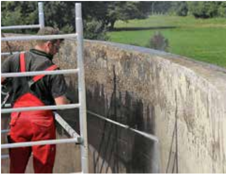
Im ersten Schritt der Betonsanierung werden die angrenzenden Bereiche des Behälters gereinigt.
