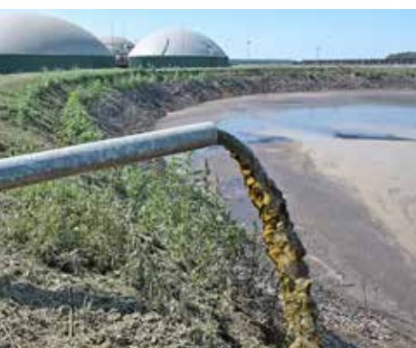
Güllelagune und Fermenter auf der Biogasanlage in Mala Branjevina
