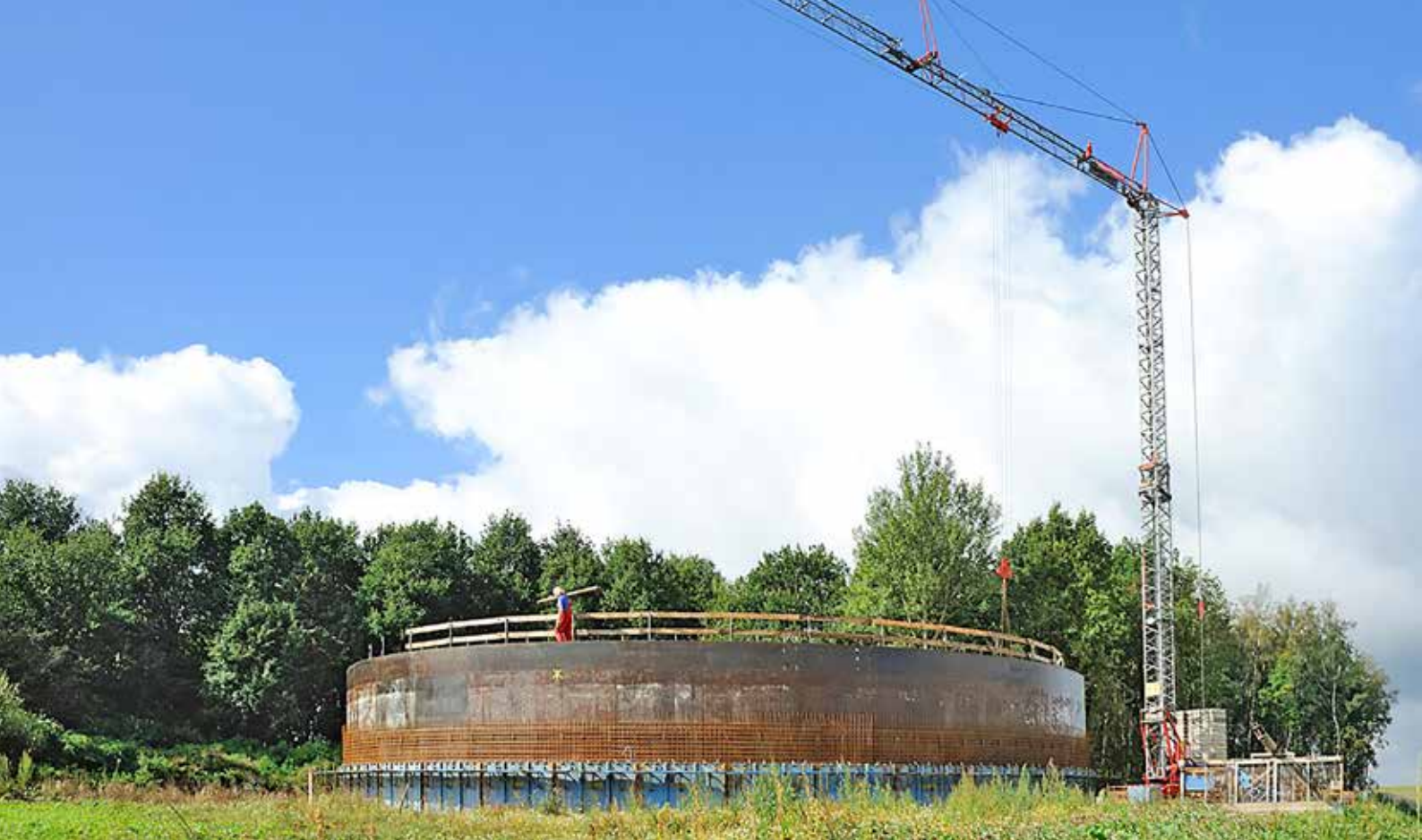
Beim Behälterbau für Biogasanlagen sind verschiedene Materialien im Einsatz.
