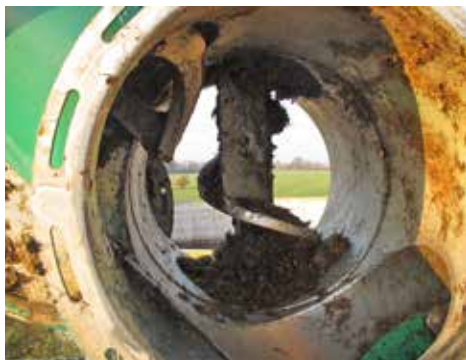
Bruch einer Substrateintragsschnecke durch Korrosion Foto: LfULG
