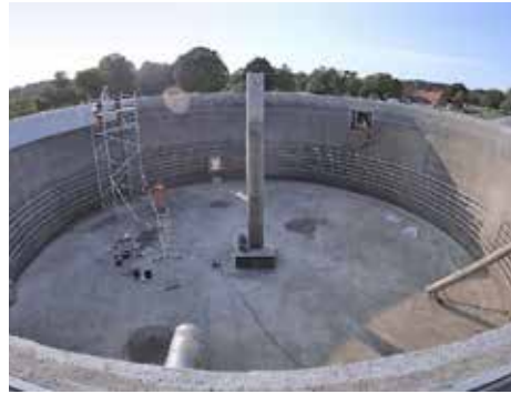
Vor dem Auftragen der Spritzbeschichtung erhält der zu sanierende obere Teil des Betonbehälters der Biogasanlage eine Grundierung.
