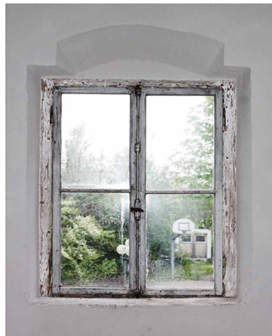
Abb. 2: Alte Schöfflerei, OG, Fenster 1.26 auf der Nordseite: Außen- und Innenansicht, Bestandsfenster im Vorzustand. Stockaußenmaß 1,14 m x 1,40 m (1,60 m 2 ).
