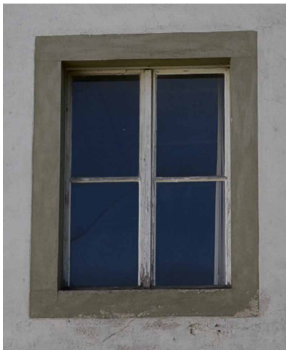
Abb. 2: Alte Schöfflerei, OG, Fenster 1.26 auf der Nordseite: Außen- und Innenansicht, Bestandsfenster im Vorzustand. Stockaußenmaß 1,14 m x 1,40 m (1,60 m 2 ).
