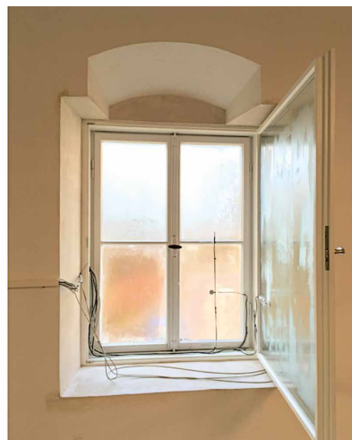
Abb. 3: Alte Schöfflerei, OG, Fenster 1.27: Innenansicht mit Erweiterung zum Kastenfenster. Links mit geschlossenem Fenster, rechts mit geöffnetem Fenster.
