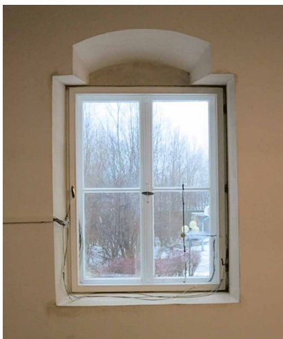
Abb. 3: Alte Schöfflerei, OG, Fenster 1.27: Innenansicht mit Erweiterung zum Kastenfenster. Links mit geschlossenem Fenster, rechts mit geöffnetem Fenster.
