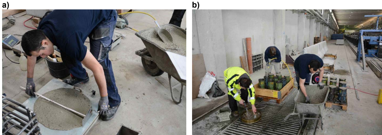
Abbildung 14 : a) Frischbetonprüfungen im Zuge des Betonierens b) Herstellung der Laborversuchskörper und Auswaschen der Gesteinskörnung
