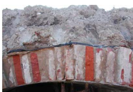
Abb. 2: Gewölbe mit aufgeklebter Sperrbahn
