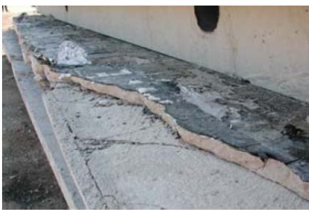
Abb. 1: Schwarzanstrich und verklebte Sperrbahn (alukaschiert)
