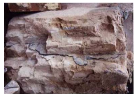
Abb. 3: Mauerwerk mit schwarzer Sperrbahn gegen aufsteigende Feuchtigkeit
