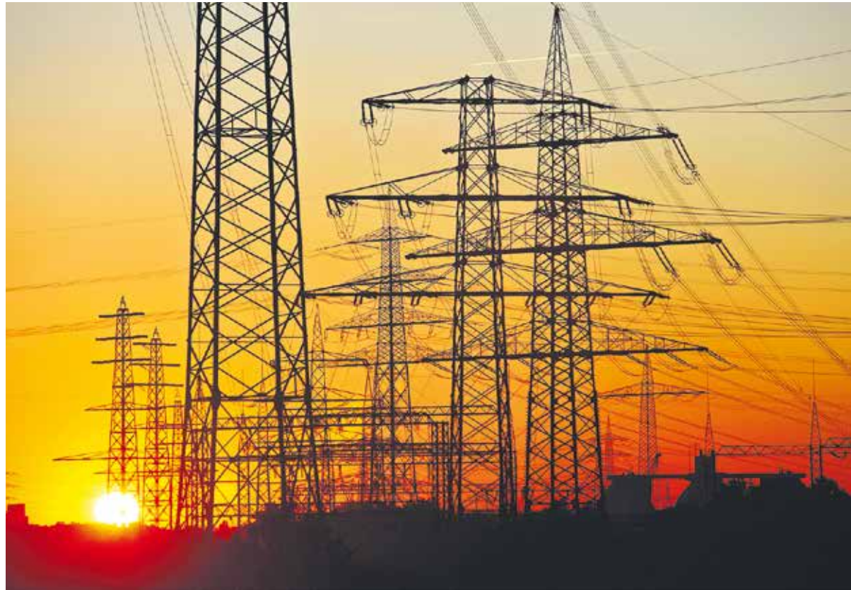
Wo genau die Gleichstromtrasse Süd-Ost verlaufen soll, ist immer noch unklar.
