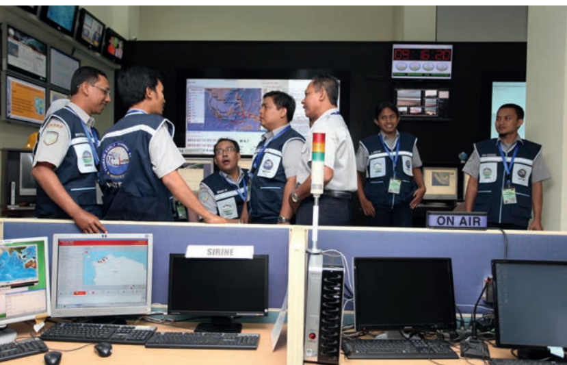
Der Kontrollraum des Warnzentrums ist rund um die Uhr besetzt. In jeder Schicht dieses sogenannten 24/7-Diensts arbeiten Schichtleiter, Operatoren und Support-Personal. (Foto: BMKG)
