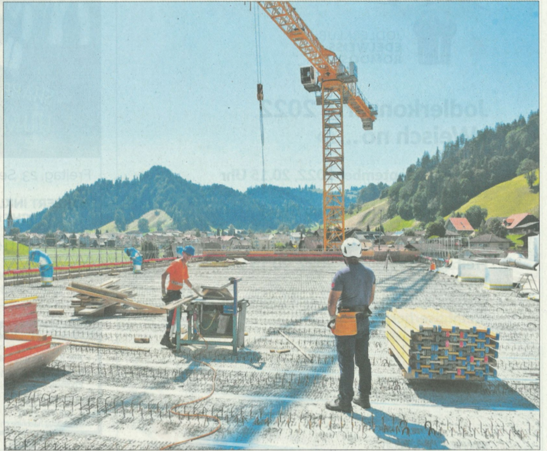
Auf dem Dach werden die Betonelemente verkleidet.
