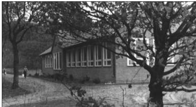
Neues Gebäude der landwirtschaftlichen Kreisberufsschule am Calberlaher Damm mit Werkraum und Küche.
