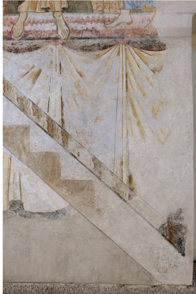
Abb. 7: Abdrücke der ehemaligen Emporentreppe in der Vorhangzone, Zustand nach der Restaurierung. Die Verdichtung von Hintergrundflächen durch die Retuschen stärkt die Silhouetten bzw. Konsistenz von Formen, Aufnahme 2022
