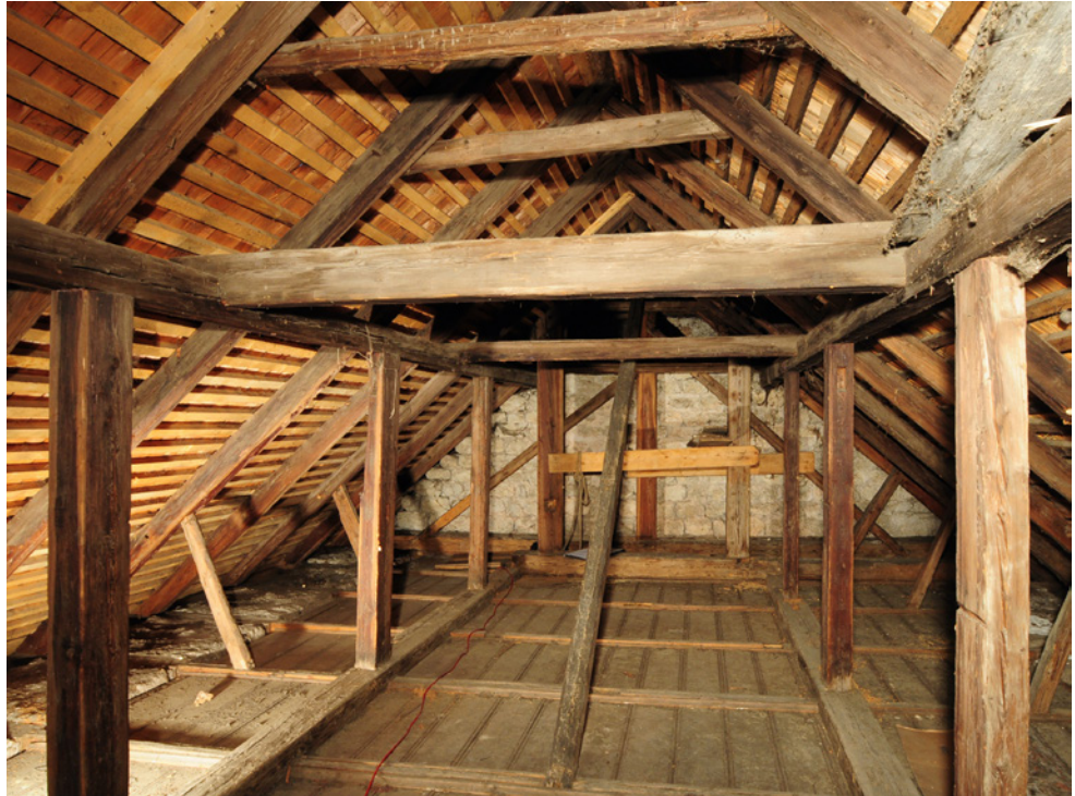
Abb. 3: Langhaus Dachraum, Blickrichtung Westen
