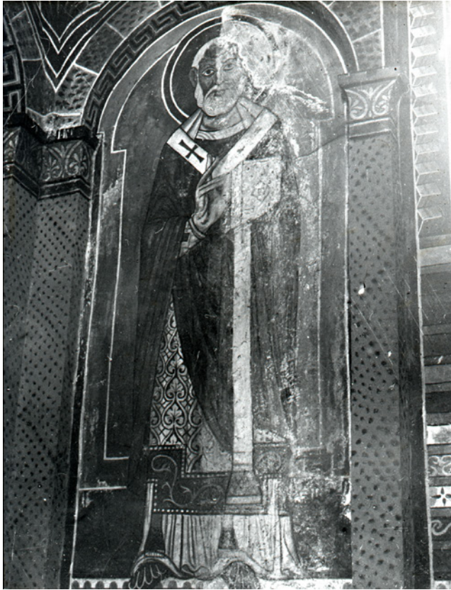
Abb. 3: Zustand während der Abnahme der Übermalung von Melicher, südliche Chorwand, Aufnahme 1939 (?)
