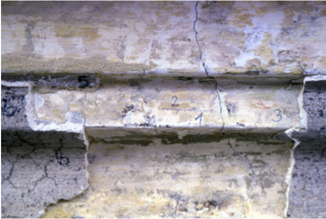
Abb. 9: Wien 3, Unteres Belvedere, Mittelrisalit, Gesims Ostseite: Schichtenbefund mit originaler Glätte und Färbelung um 1716 und „Marmorino“ nach 1947
