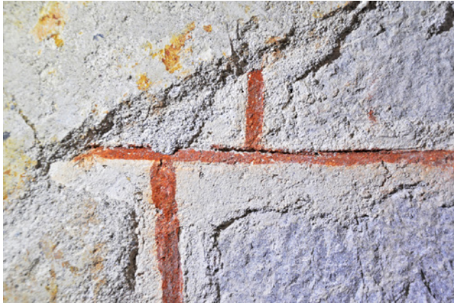
Abb. 3: Pürgg, Johanneskapelle, Innenseite südlicher Triumphbogen: rote Quadermalerei unter Malereiputz
