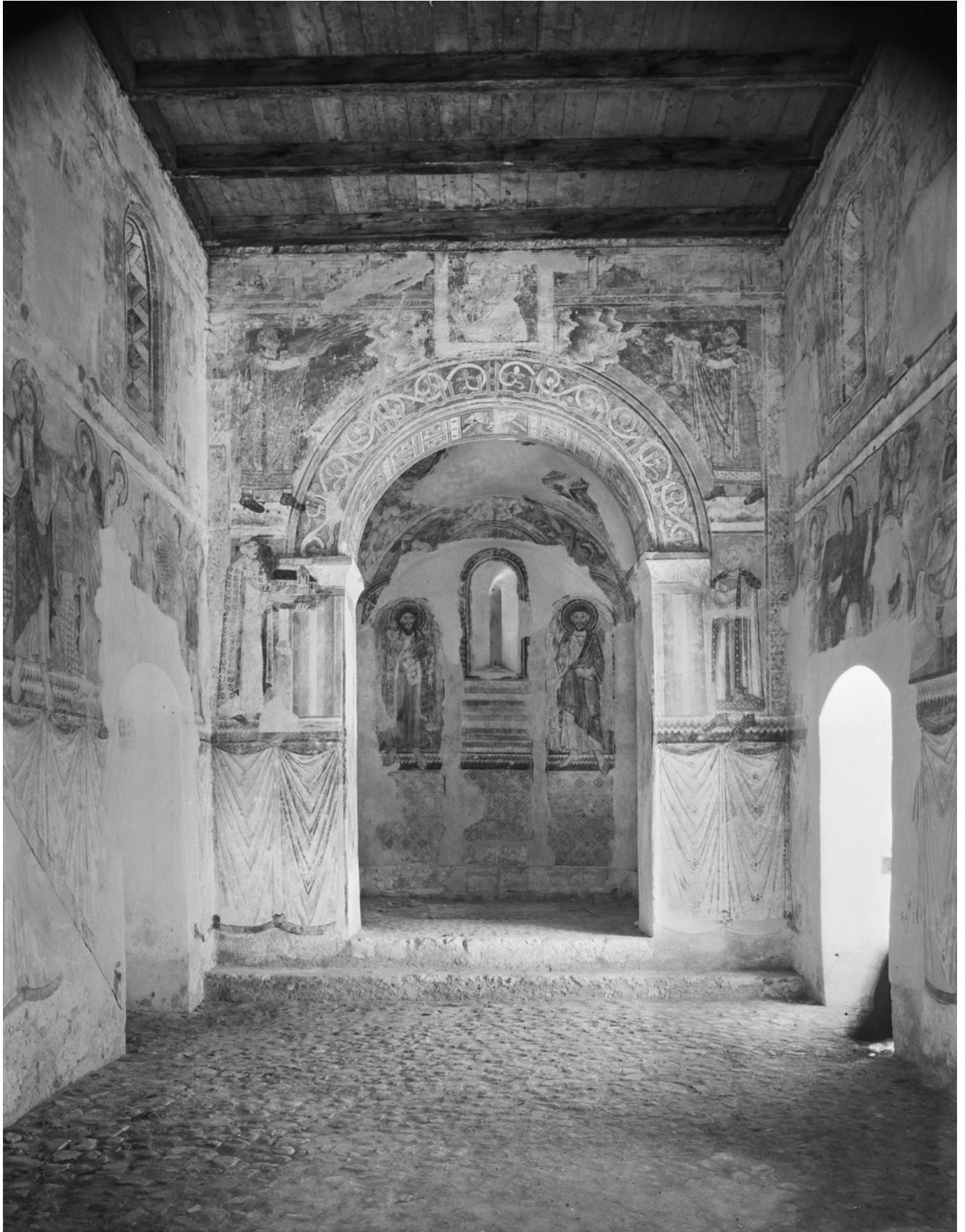
Abb. 6: Blick auf die Triumphbogenwand und in den Chor, die großen Fehlstellen sind mit Kalkmörtel bereits wieder verputzt, Aufnahme 1943
