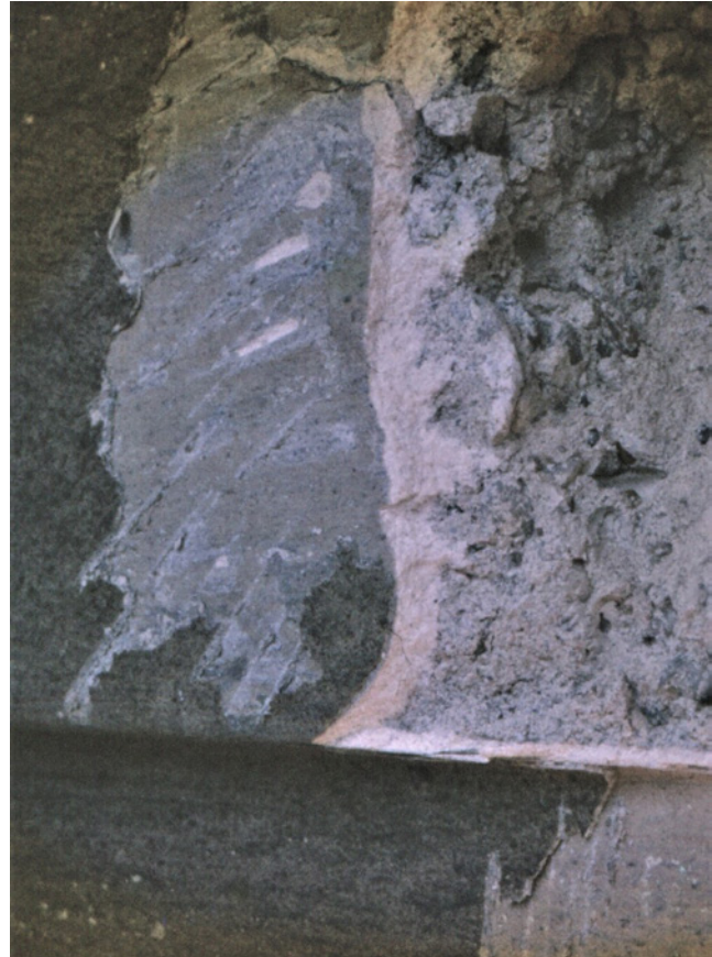
Abb. 10: Wien 9, Stadtbahnstation Nußdorferstraße, Otto Wagner 1897, Ostfassade: weißer Originalverputz mit späterem Naturputz-Überrieb
