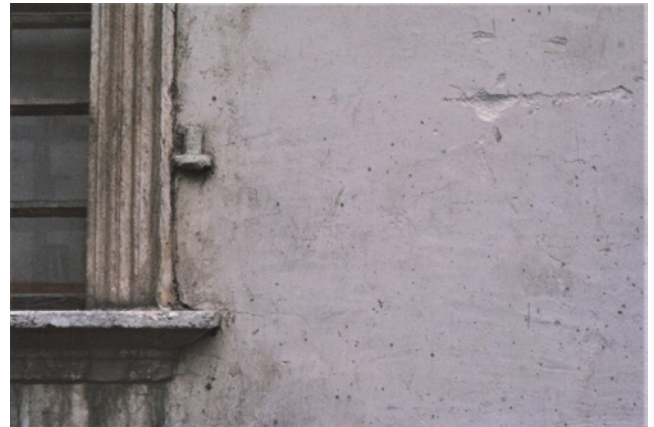
Abb. 15: Spittal an der Drau, Schloss Porcia, Eingangsfassade: am Scharnier der ehem. Fensterflügel erkennt man die Dicke des neuen Palladianerputzes
