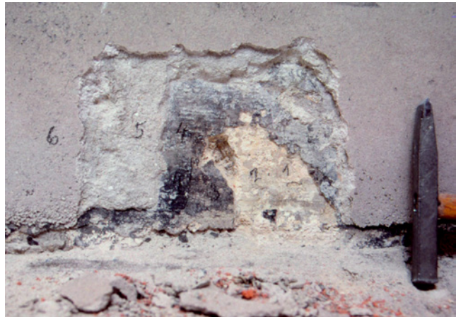
Abb. 13: Wien 1, Peterskirche, linker Fassadenturm, Nische der Petrusfigur: Schichtenuntersuchung, „Marmorino“ der Restaurierung nach 1950
