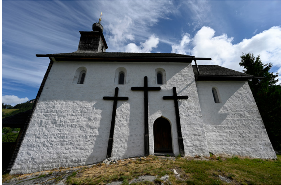
Abb. 1: Die Südseite der Johanneskapelle in Pürgg mit den Satteldächern über Chor und Langhaus sowie dem barocken Glockenreiter (Aufnahme: 15. Juli 2021)
