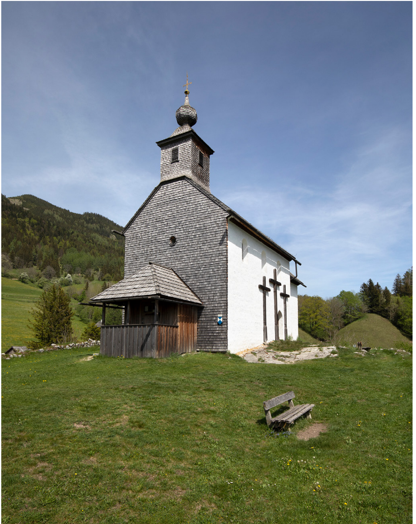
Nr. 1: Außenansicht der Johanneskapelle in Pürgg, Aufnahme 2022
