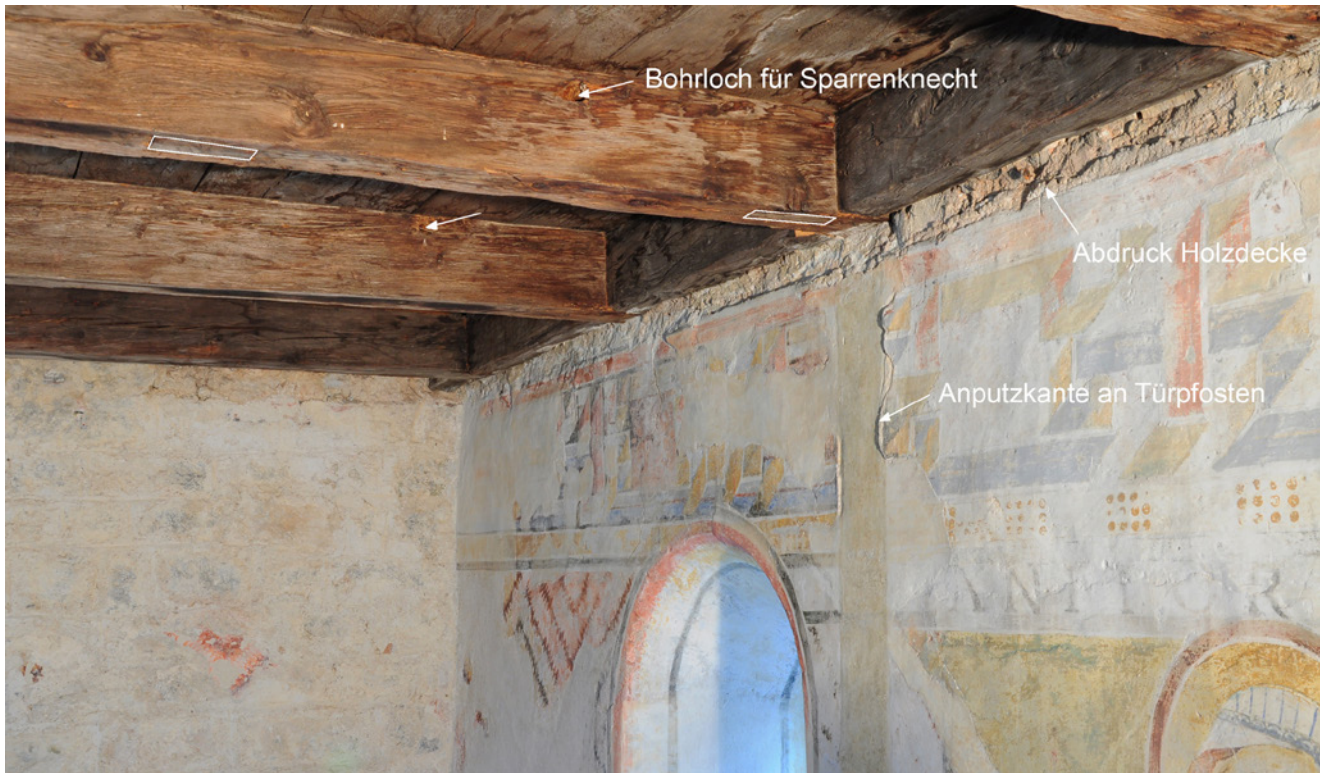
Abb. 5: Pürgg, Johanneskapelle, Nordwestecke Kapellenschiff: Zapflöcher von Emporenzugang an Deckenbalken und Abdruck Türpfosten und Holzdecke im Malereiputz
