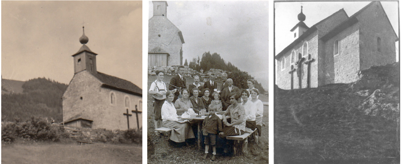
Abb. 1: Außenansichten der Kirche um 1894
