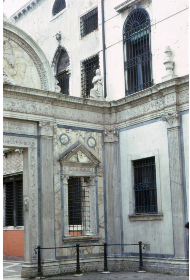
Abb. 6: Venedig, Scuola di San Giovanni Evangelista, nach Restaurierung und Ergänzung des weißen „Marmorino“ mit „Schatten“-Rand in der unteren Hälfte um 1980
