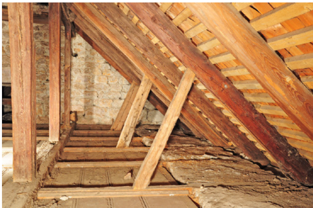
Abb. 9: Pürgg, Johanneskapelle, Ausschnitt Dachraum Kapellenschiff gegen Osten: Sparrendach mit stehendem Stuhl, um 1125, Sparrenknechte in den 1940er Jahren versetzt
