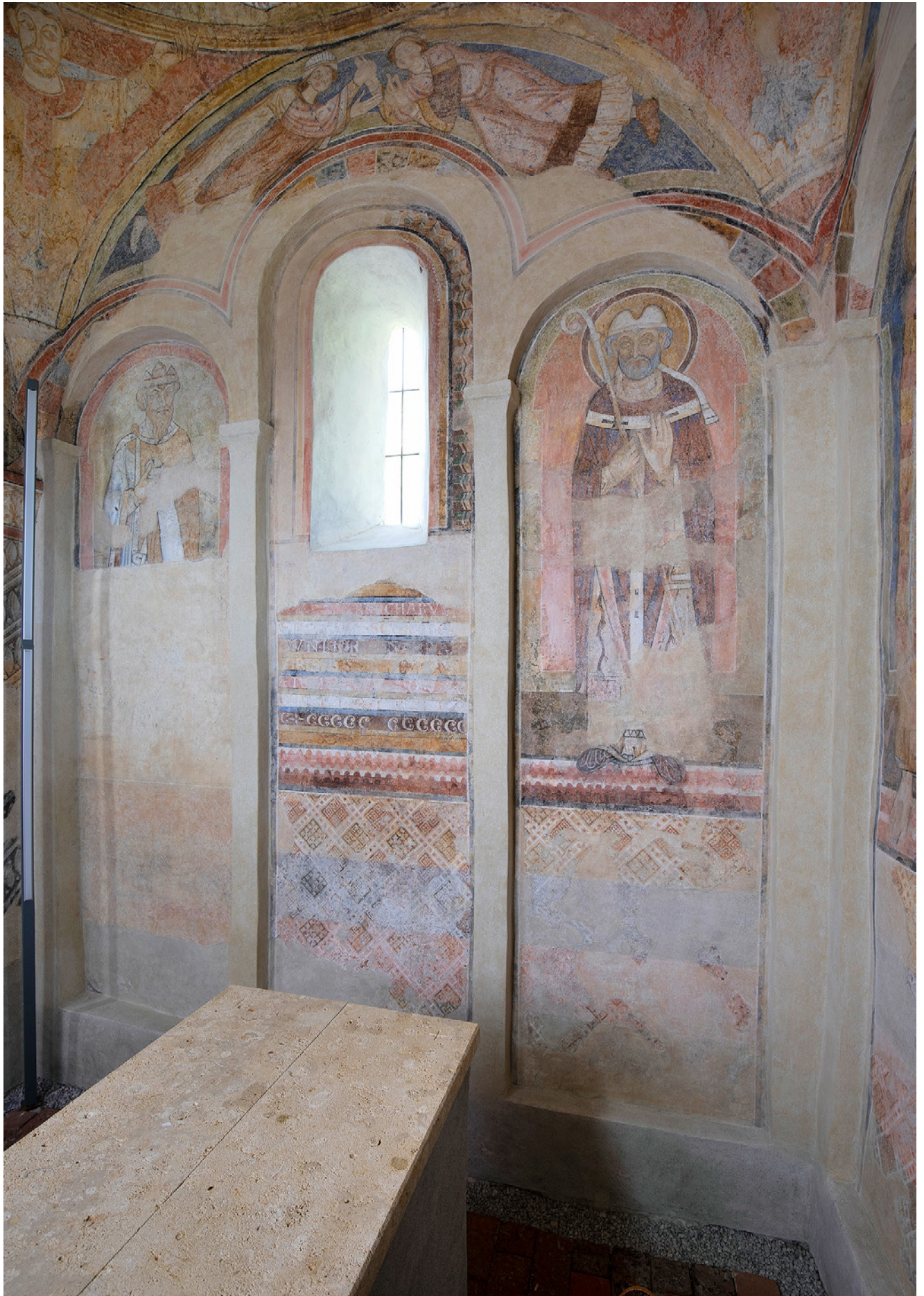
Nr. 5: Nördliche Wand im Chorraum, Aufnahme 2022
