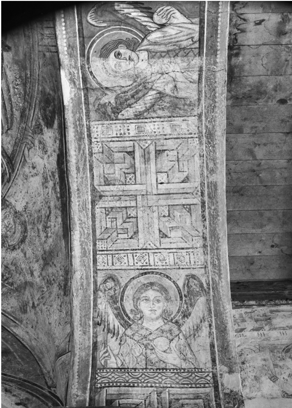
Abb. 8: Blick in die Laibung der Triumphbogenwand, gut erkennbar sind noch Reste der Stil-Restaurierung von Melicher, Aufnahme 1943
