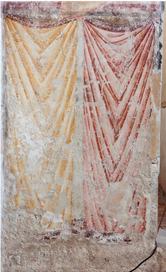
Abb. 12: Vorhangzone an der Triumphbogenwand, Zustand nach der Reinigung, Aufnahme 2017
