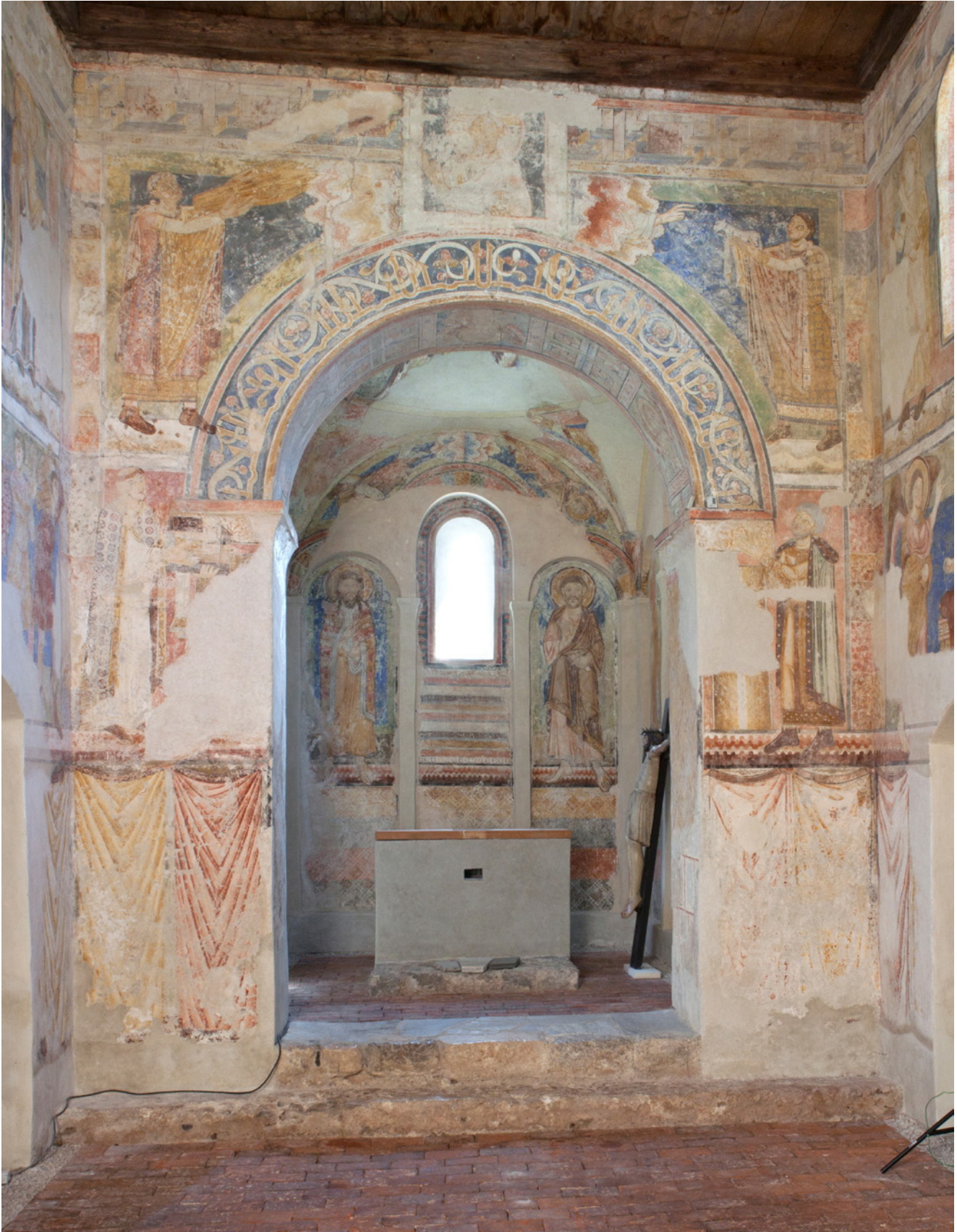
Nr. 10: Triumphbogenwand, Zustand während der Restaurierung, Aufnahme 2018
