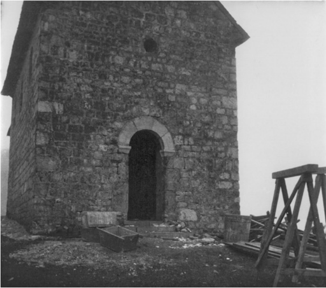
Abb. 5: Außenansicht der Westseite mit diversen Materialresten; gut erkennbar sind u. a. Gerüstböcke, Gerüstbretter und Holzbottiche, Aufnahme um 1940
