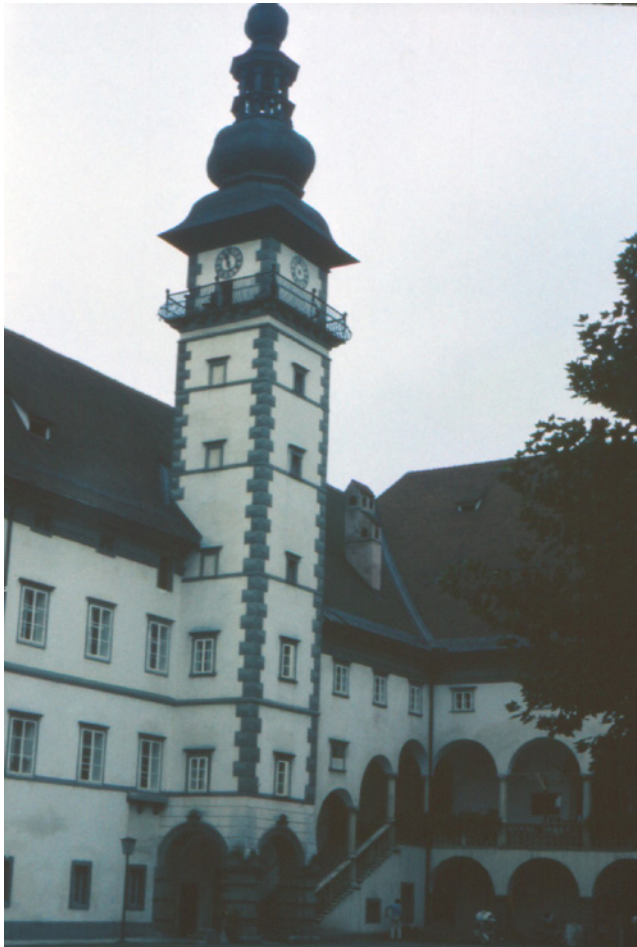
Abb. 14: Klagenfurt, Landhaus, Hofseite nach Restaurierung 1969
