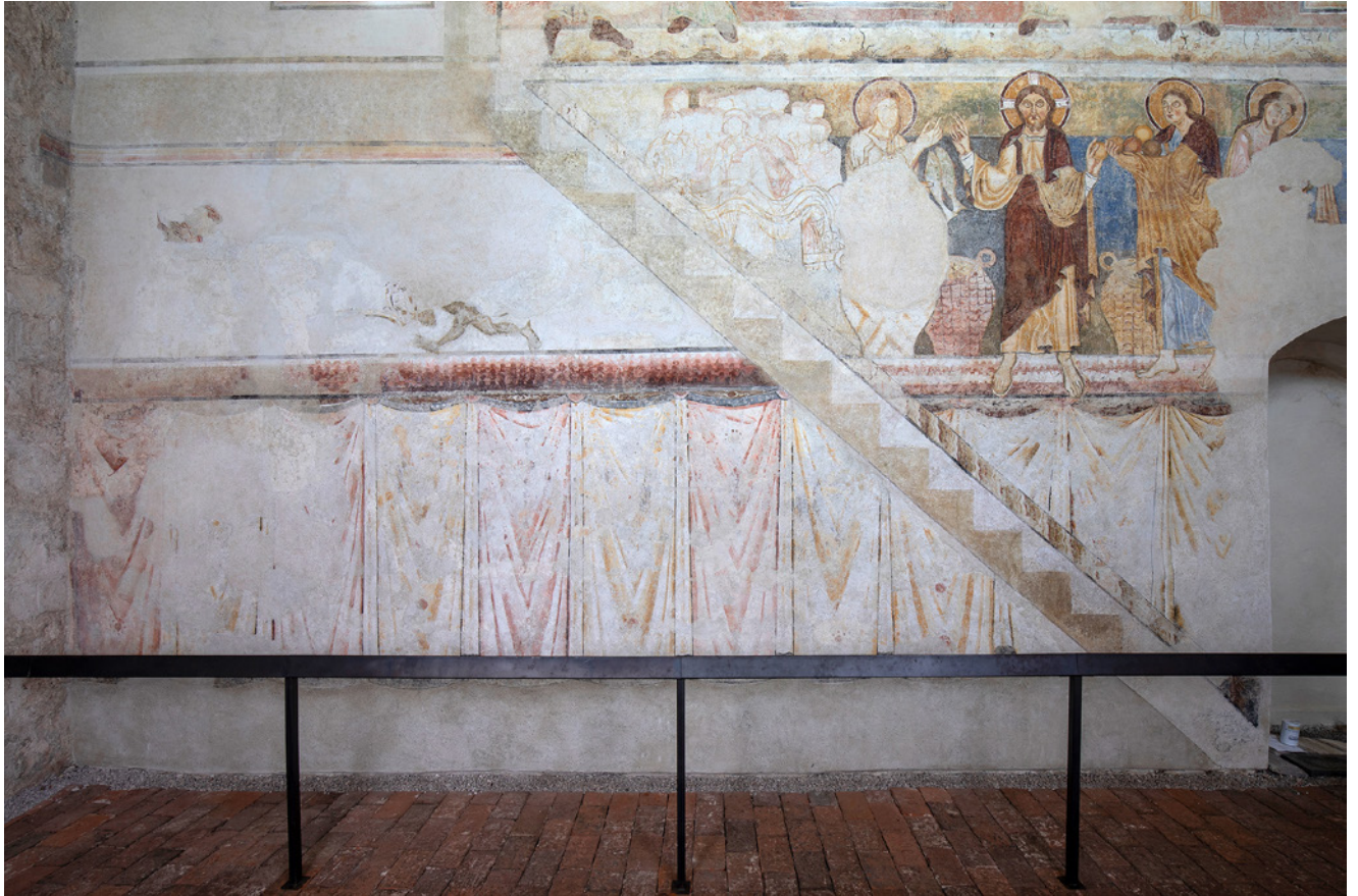
Nr. 15: Nördliche Langhauswand, Zustand nach der Restaurierung, Aufnahme 2022
