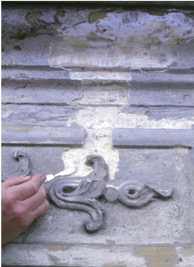
Abb. 12: Wien 3, Unteres Belvedere, Mittelrisalit, Ostgesims: Schichtenbefund mit „Marmorino“auflage nach 1947
