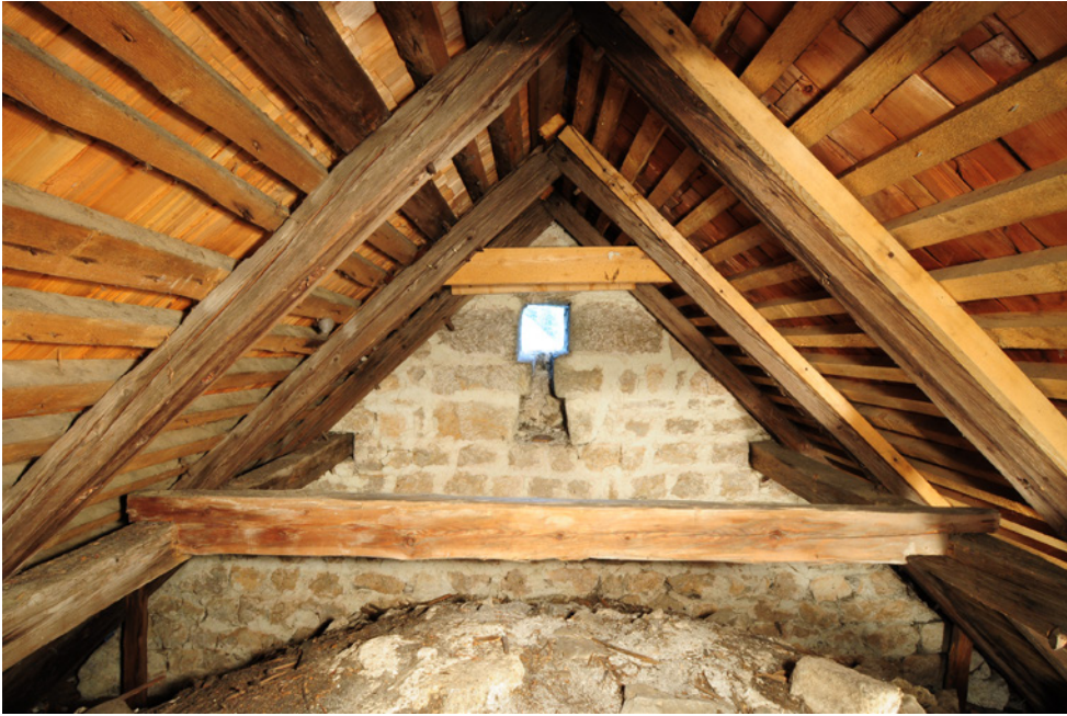
Abb. 5: Chordachraum, Blickrichtung Osten
