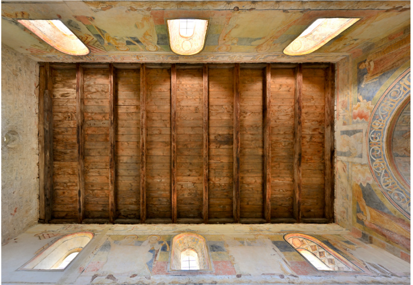
Abb. 2: Untersicht Flachdecke Langhaus mit den weitgehend bauzeitlichen Deckenbalken
