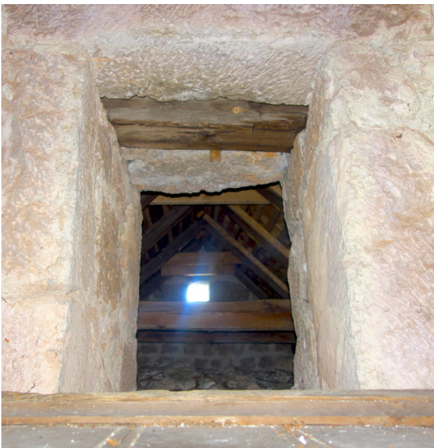
Abb. 6: Der Durchlass zum Chordachraum in der östlichen Langhaus-Giebelwand mit Untersicht des Sturzbalkens puer-42
