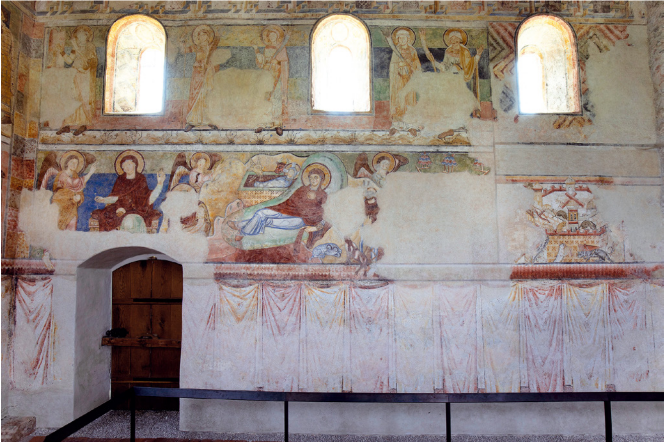
Nr. 19: Südliche Langhauswand, Zustand nach der Restaurierung, Aufnahme 2022
