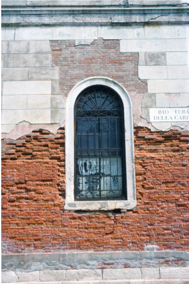
Abb. 7: Venedig, Galleria dell'Accademia (ex-convento della carità): stark salzbelastete Ziegelmauern, dünner Original(?) putz und plattige (spätere?) Marmorinoglätten als Quaderung
