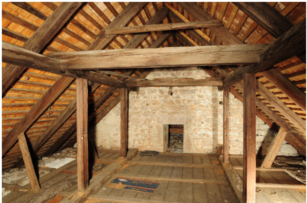
Abb. 4: Langhaus Dachraum, Blickrichtung Osten
