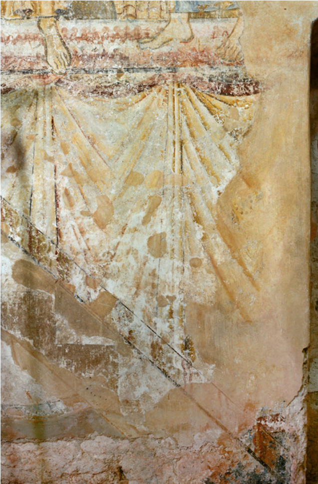
Abb. 6: Abdrücke der ehemaligen Emporentreppe in der Vorhangzone, Zustand vor der Restaurierung, Aufnahme 2011
