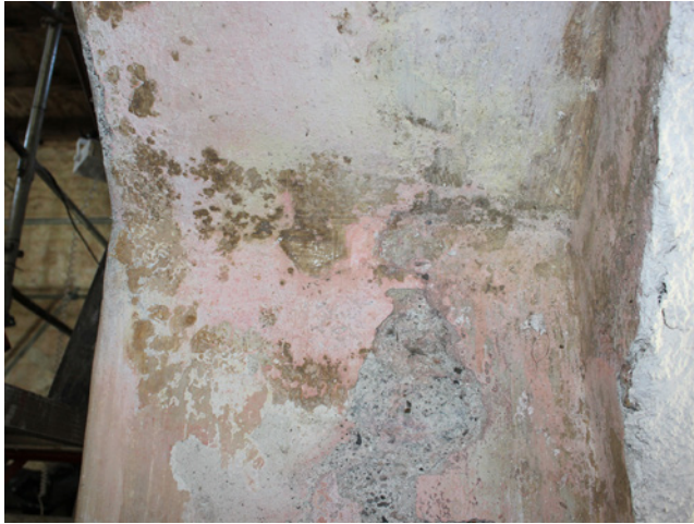
Abb. 11: Rosa Verfärbungen durch Mikroorganismen und Feuchte und Salz induzierte Schädigung des Verputzes
