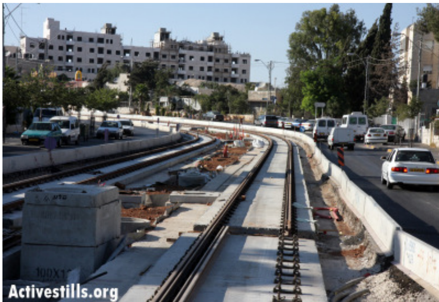
Bild: Baustelle der Strassenbahn in Jerusalem
