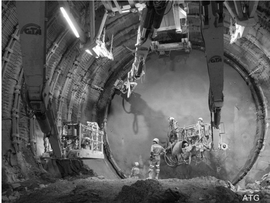
Abbildung 4: Streckenausbaumaschine beim Ausbau setzen
