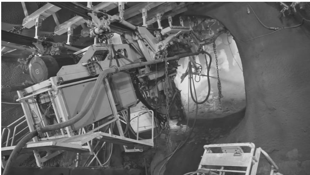
Abbildung 15: Spritzbeton einbringen
