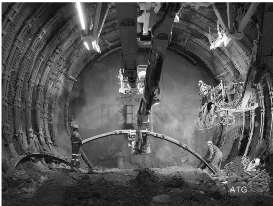
Abbildung 5: Streckenausbaumaschine beim Ausbau setzen
