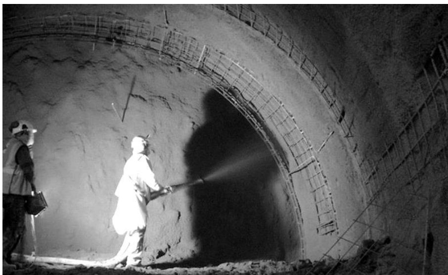
Abbildung 4. Spritzbeton einbringen
