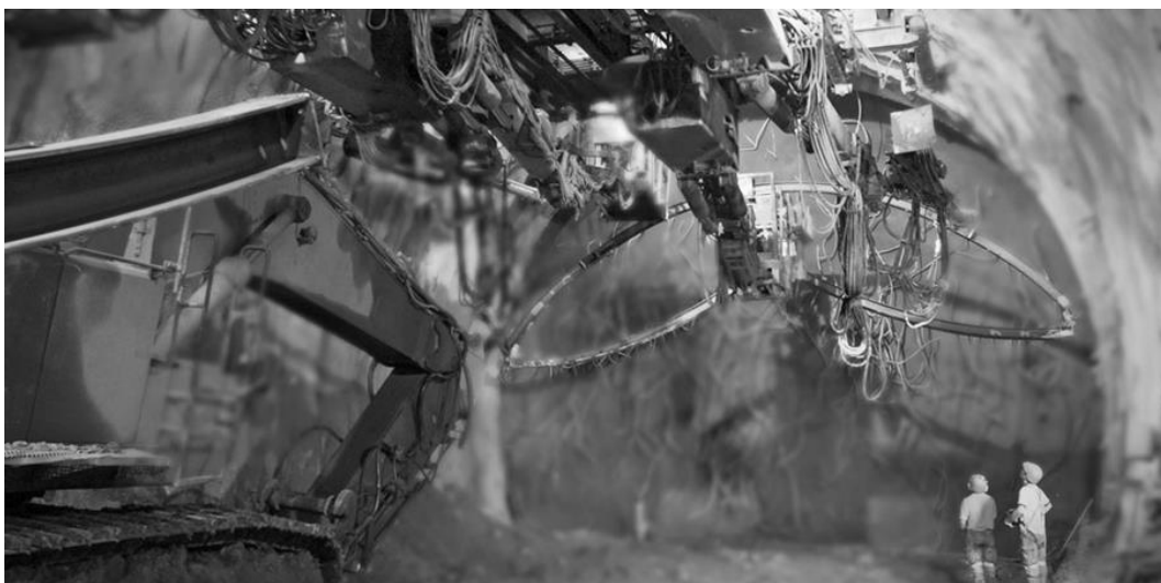
Abbildung 8: Ausbau (HEB 220) setzen
