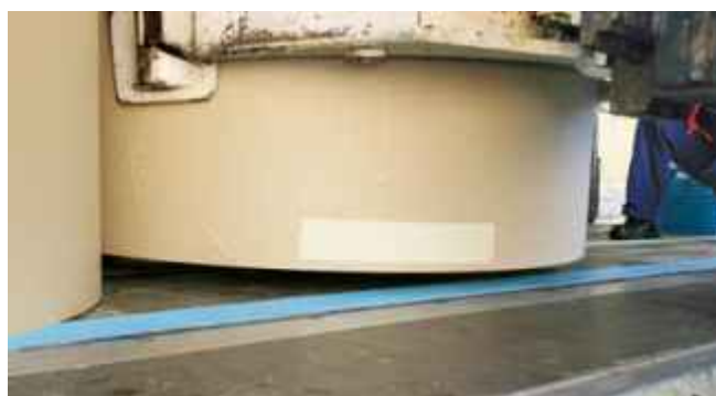
Das punktgenaue Absetzen ist Präzisionsarbeit.
